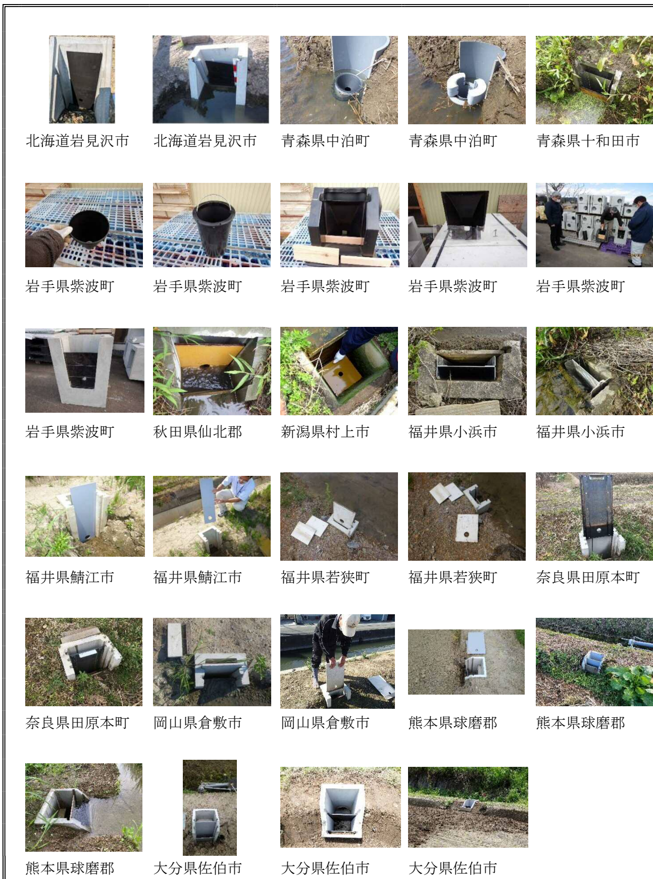
図 - 1 流出量調整器具（機能分離型）の写真
