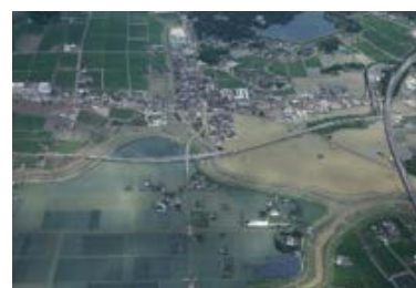
合流部での浸水状況
