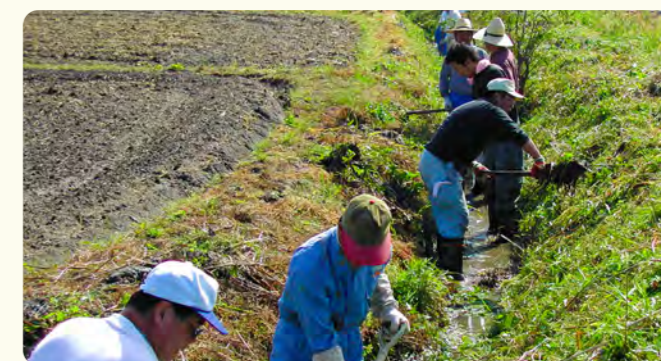
水路の泥上げ
