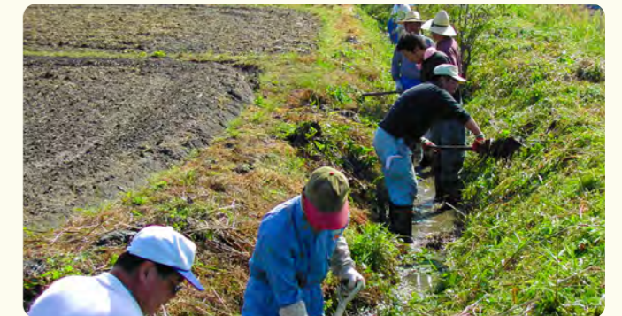
水路の泥上げ
