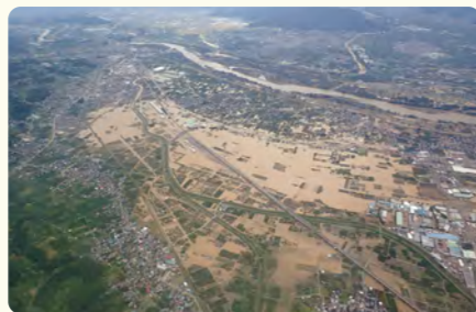
千曲川における浸水被害 令和元年東日本台風(長野県長野市) 写真提供:北陸地方整備局
