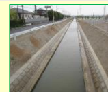
排水路の整備
