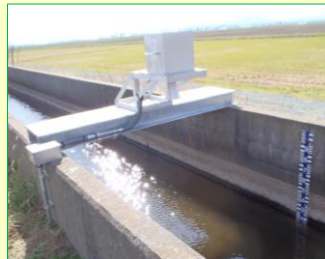
水位計の設置
