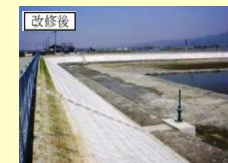
ため池の法面改修
