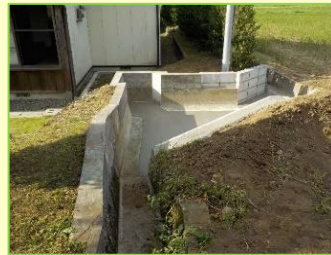
排水路側壁嵩上げ
