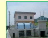
排水機場の整備
