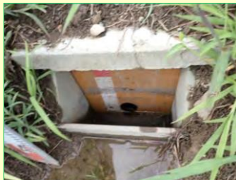
排水調整板の設置
