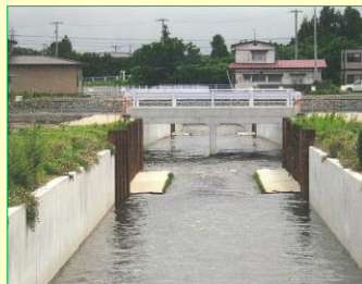
排水路の整備後 (排水能力 Q=45.0\text{m}^3/\text{s} )
