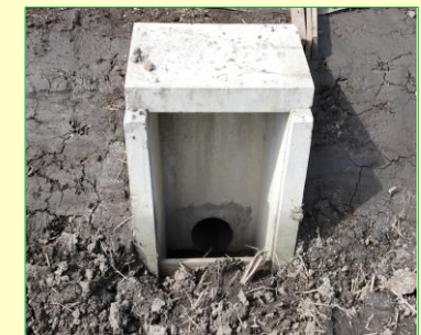
排水口の整備
