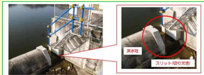
農業用ため池の洪水調節機能を強化するための「洪水吐きスリット」設置状況
