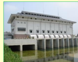
排水機場の管理
