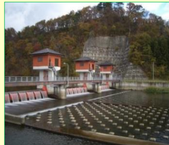
頭首工の管理
