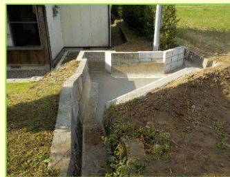
排水路側壁嵩上げ
