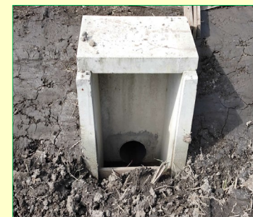
排水口の整備
