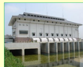
排水機場の管理
