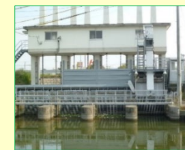
排水樋門の管理
