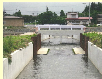
排水路の整備後 (排水能力 Q=45.0\text{m}^3/\text{s} )
