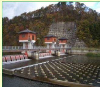
頭首工の管理
