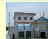
排水機場の整備
