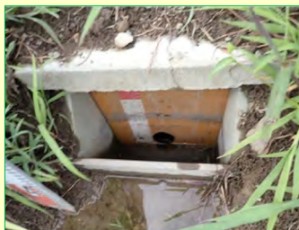
排水調整板の設置
