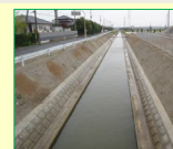
排水路の整備
