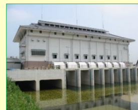
排水機場の管理
