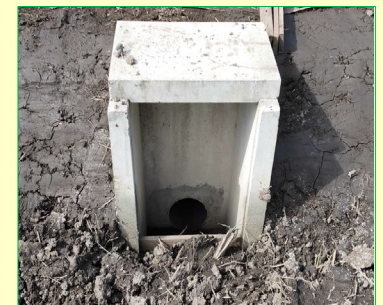
排水口の整備
