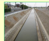
排水路の整備
