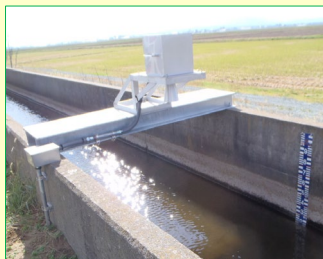
水位計の設置
