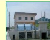
排水機場の整備
