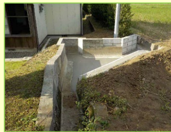
排水路側壁嵩上げ
