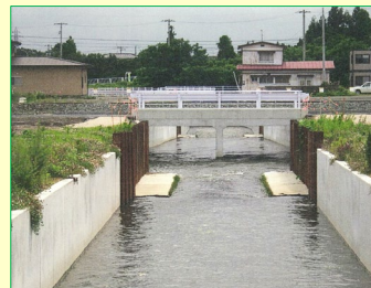
排水路の整備後 (排水能力 Q=45.0\text{m}^3/\text{s} )
