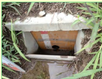
排水調整板の設置
