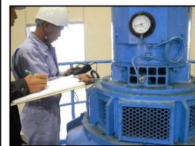
（ポンプの点検整備）
