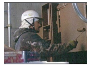
（ゲートの塗装）
