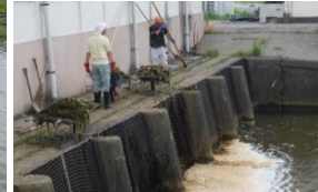
スクリーンの除塵作業
