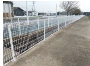
（転落防止対策） 転落防止柵
