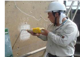
老朽化した施設の機能診断
