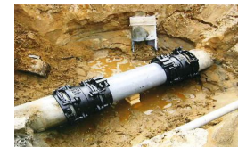
漏水防止のための整備
