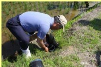
田んぼダム用 水位調整管の 設置
