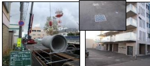
下水道雨水管の整備
