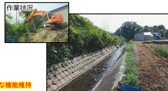
・市内6河川において伐開・浚渫を実施（滝川市）
