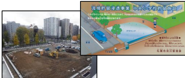
貯留施設の整備
