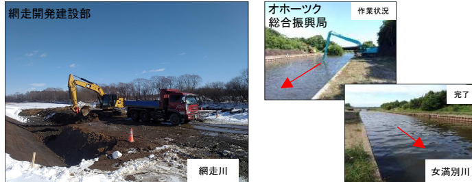
河道掘削実施状況
