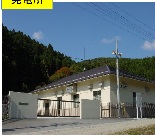
小水力 発電所
