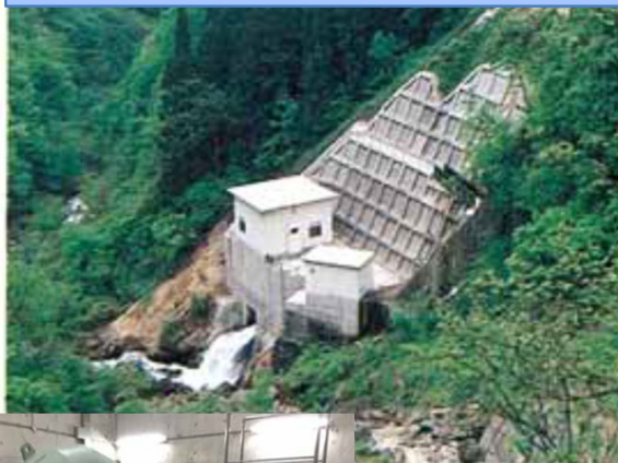
大平沼発電所 （平成3年建設当時）
