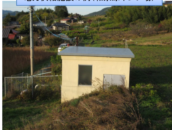
電力供給施設の例(和泉原ポンプ場)
