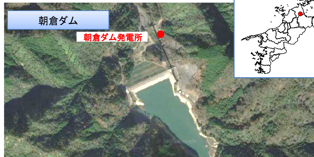
小水力発電施設
