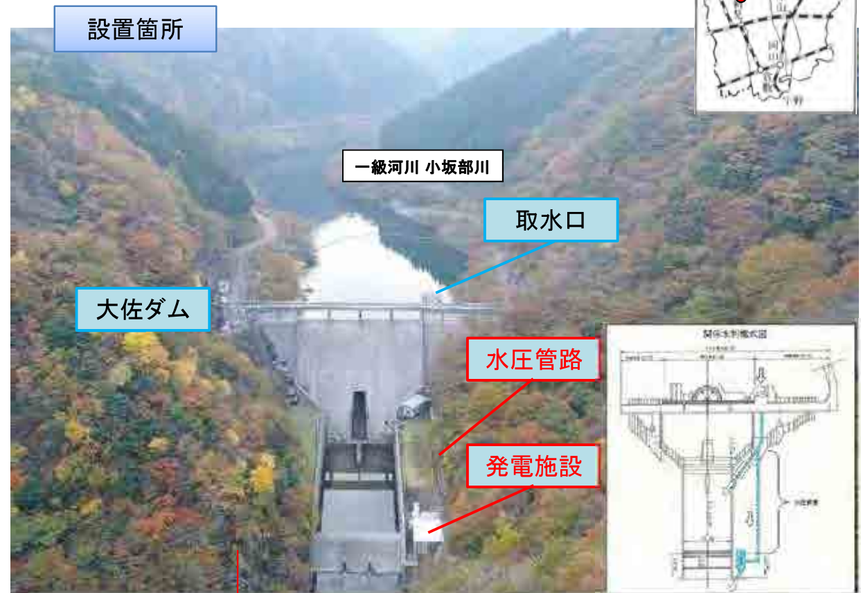
発電施設 (横軸フランシス水車)
