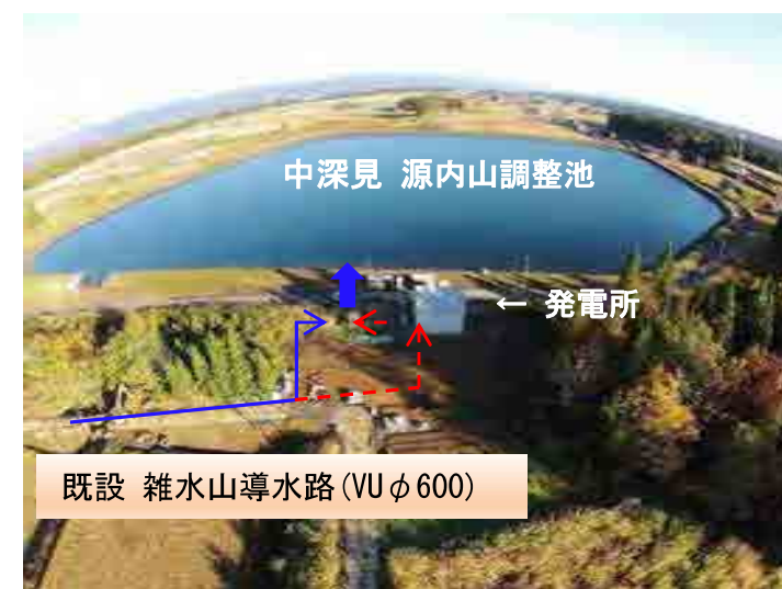
雑水山第二発電所と源内山調整池（上空より）
