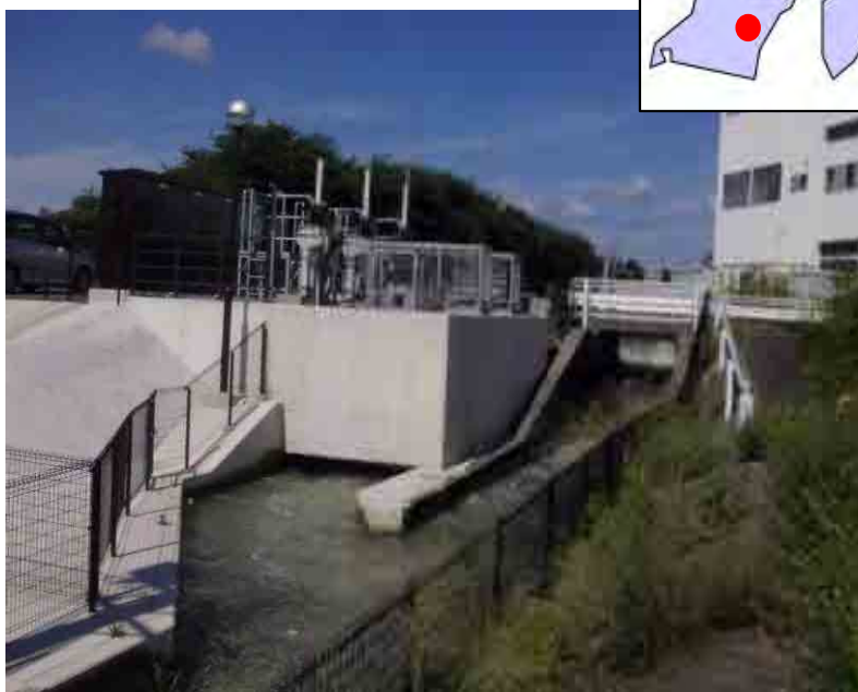
細島発電所全景
