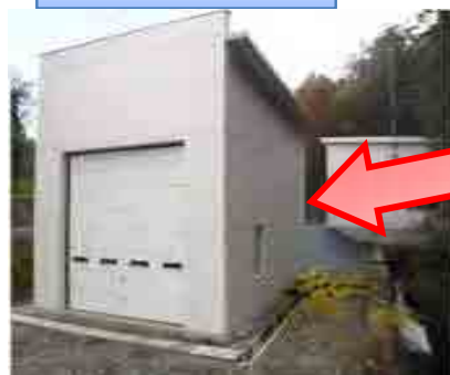
小水力発電施設
