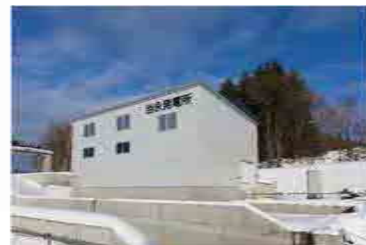
当永発電所全景
