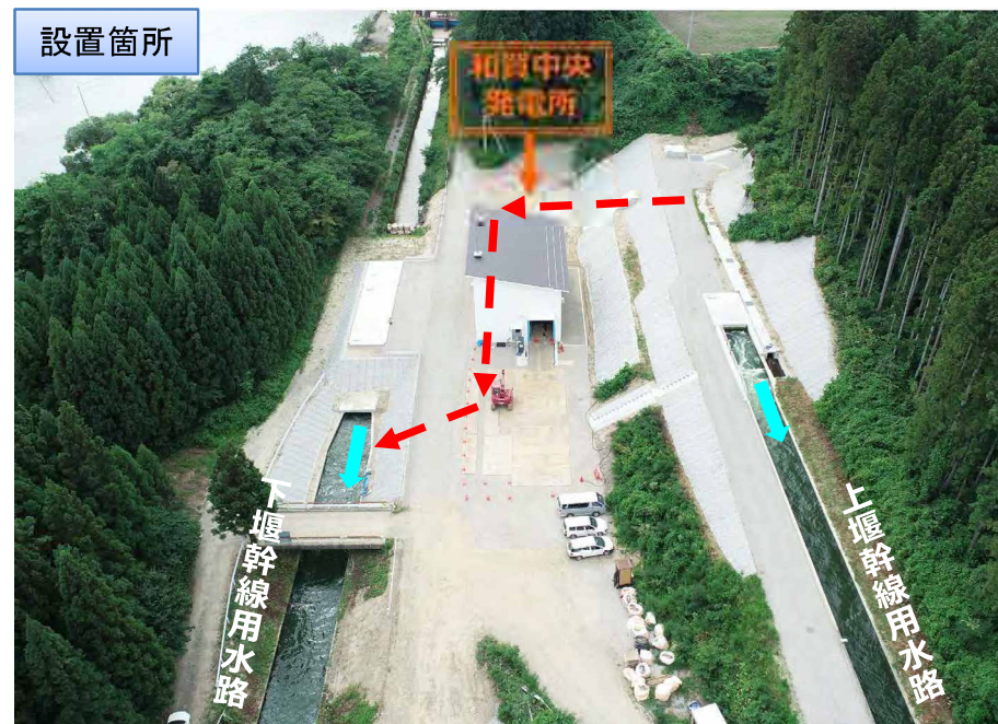
小水力発電施設
