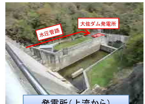
発電所(上流から)
