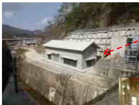
三川ダム小水力発電所
