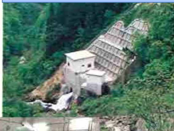
大平沼発電所 （平成3年建設当時）
