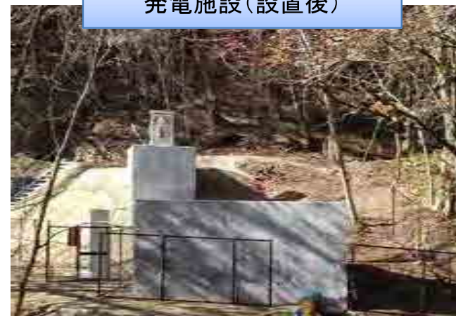
発電施設(設置後)
