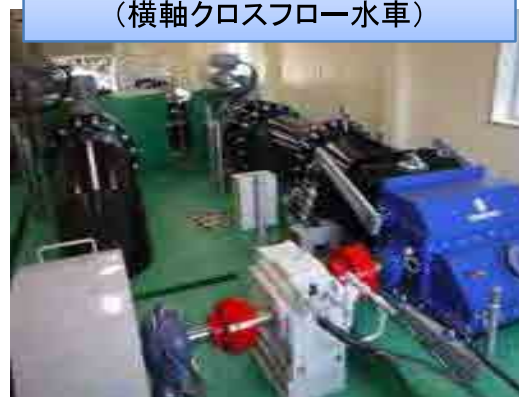
水車発電機 （横軸クロスフロー水車）
