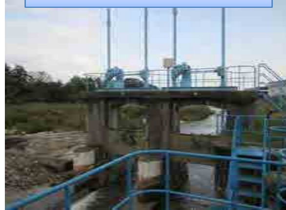
用水取入口（新堰頭首工）
