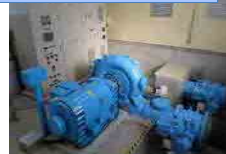
水車発電機(横軸フランシス水車)
