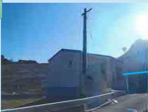
小水力発電施設
