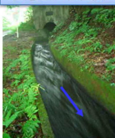
発電地点(設置前)
