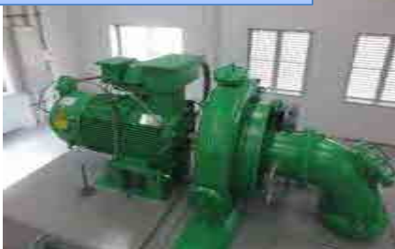
水車発電機(横軸フランシス水車)
