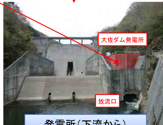
発電所(下流から)
