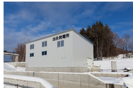
当永発電所全景
