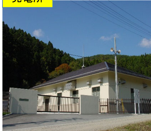
小水力 発電所
