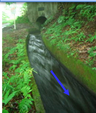
発電地点（設置前）
