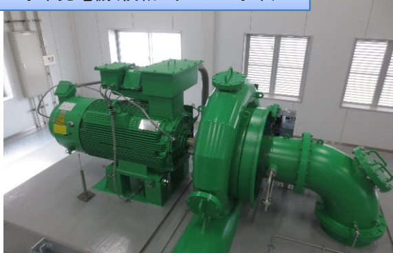
水車発電機(横軸フランシス水車)
