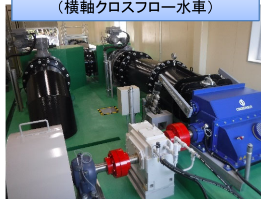
水車発電機 (横軸クロスフロー水車)
