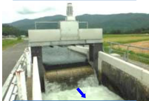
水車発電機(4号落差工)
