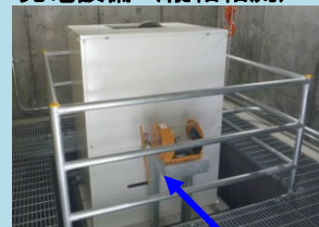
発電設備（縦軸軸流）
