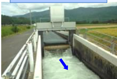
水車発電機(4号落差工)
