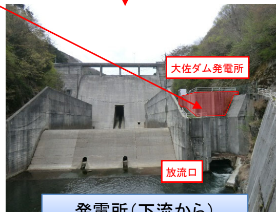
発電所(下流から)
