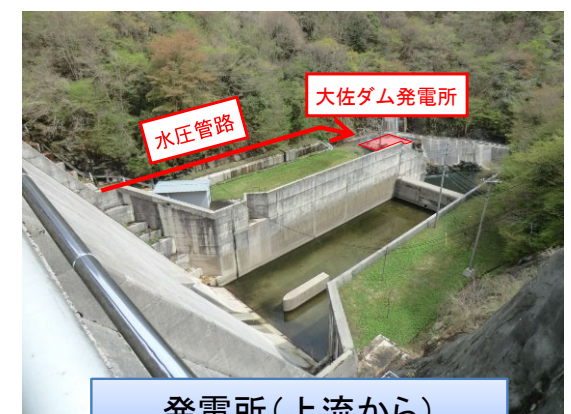
発電所(上流から)
