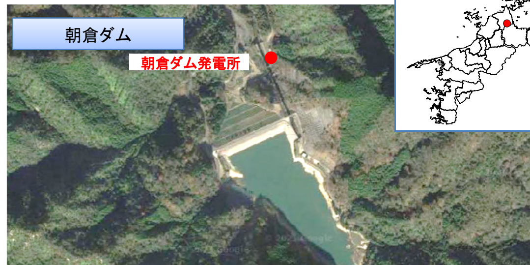
小水力発電施設
