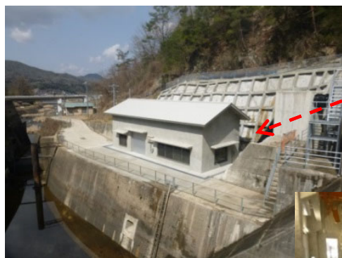
三川ダム小水力発電所
