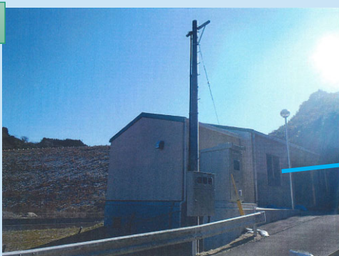
小水力発電施設
