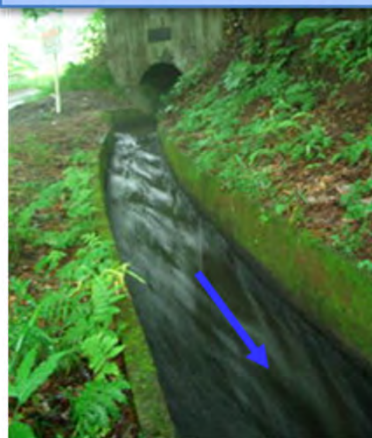
発電地点(設置前)
