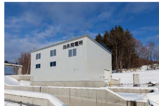
当永発電所全景
