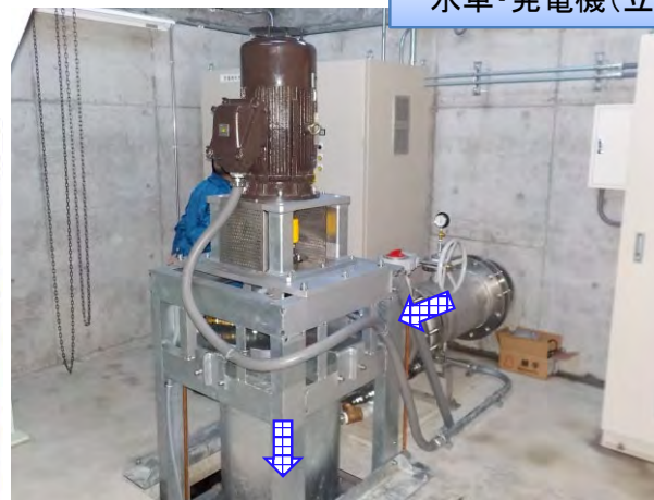
水車・発電機(立軸スクルー水車)
