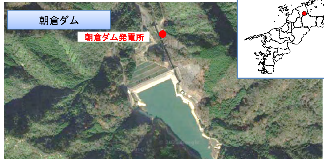
小水力発電施設
