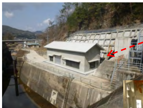
三川ダム小水力発電所
