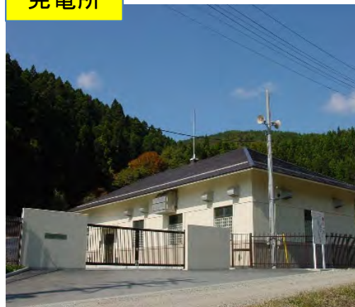
小水力 発電所
