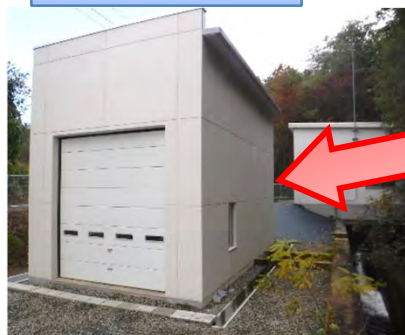
小水力発電施設
