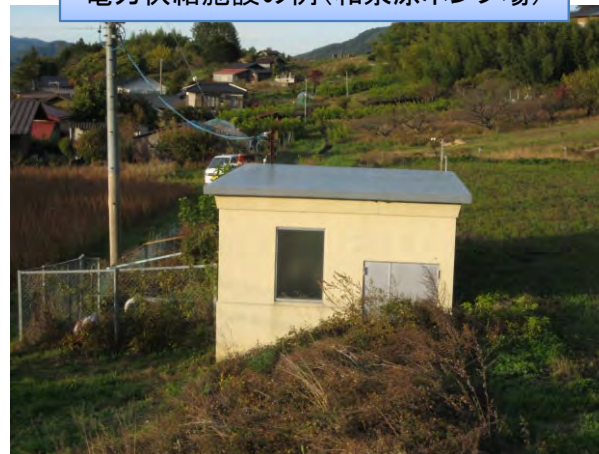
電力供給施設の例(和泉原ポンプ場)
