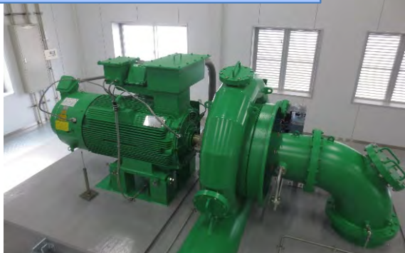
水車発電機(横軸フランシス水車)
