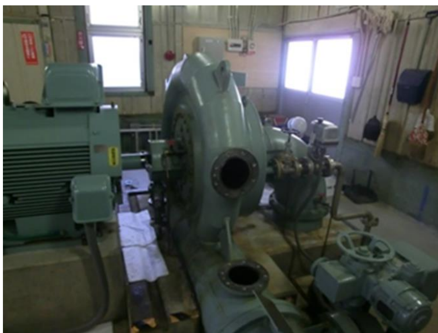
図 4-4 水車ケーシングマンホール取り外し状況（人力による塵芥除去） （写真提供：東京発電株式会社）
