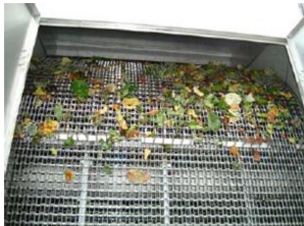
図 3-8 網目(メッシュ)状スクリーンの例(写真提供：株式会社広洋技研)
