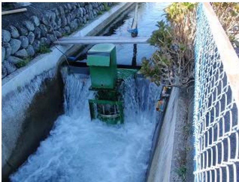
図 4-2 2 水車全景（下流より）
