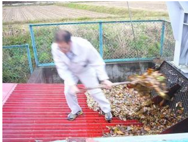
図 4-17 人力による塵芥掻き揚げの例
