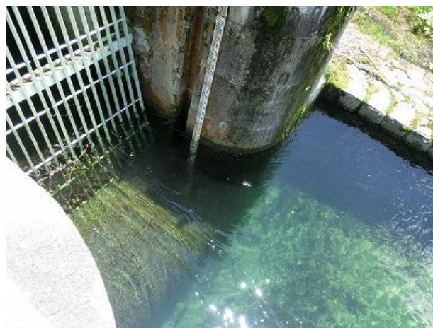
図 4-18 バースクリーンの設置例
