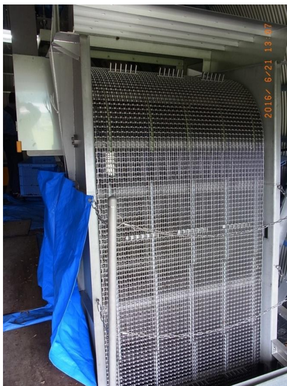
図 4-1 1 鋼板ネット型除塵機設置例(写真提供：東京発電株式会社)
