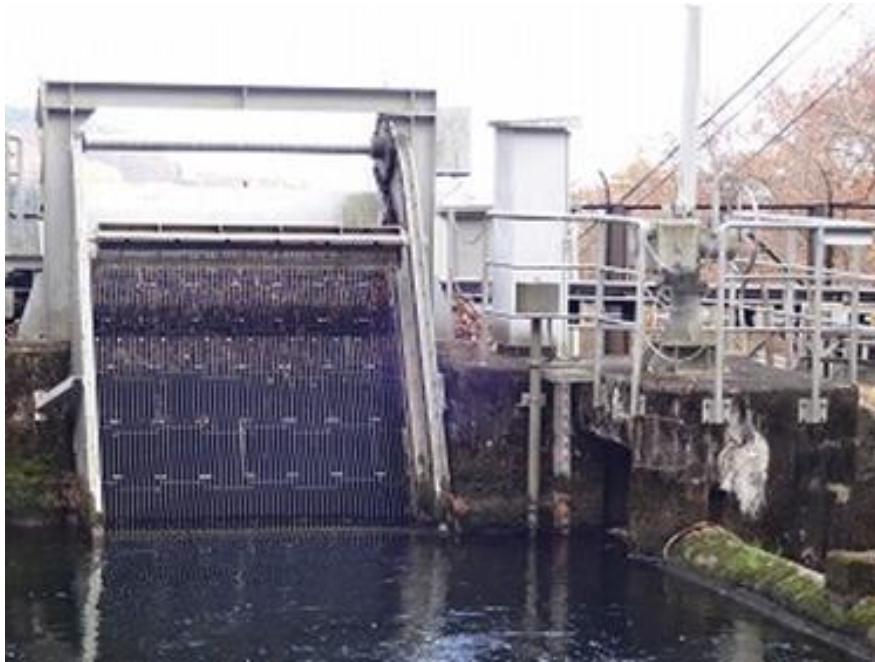
図 4-2 レーキ形除塵機（背面降下前面掻揚式）（写真提供：東京発電株式会社）
