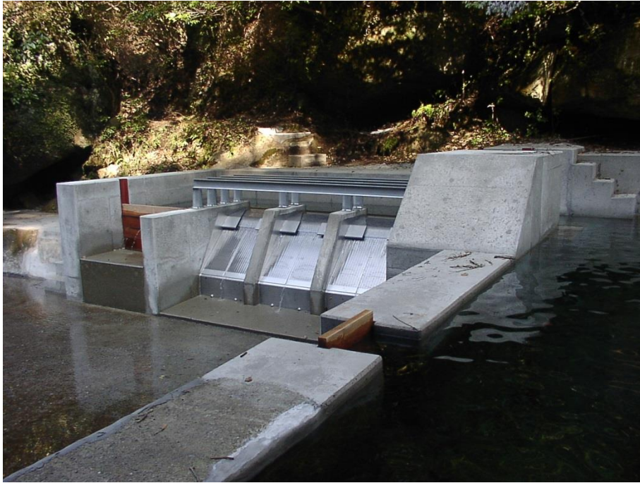
図 4-26 3面スクリーンの設置例(写真提供：日本エンジニア株式会社)
