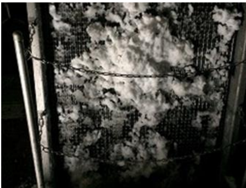
図 4-15 ネットに付着するスノージャム(写真提供：東京発電株式会社)
