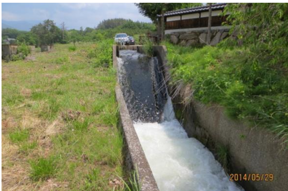
図 3-1 農業用水路落差工（出典：東京発電株式会社）
