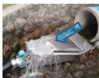
取水用柵の状況
