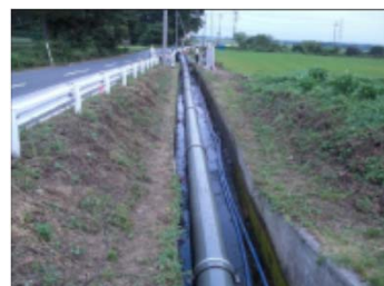
水路内に導水管を布設
