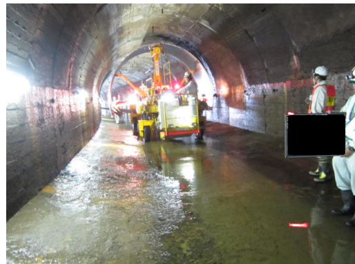
写真-6.5.7-8 クラウン材坑内運搬
