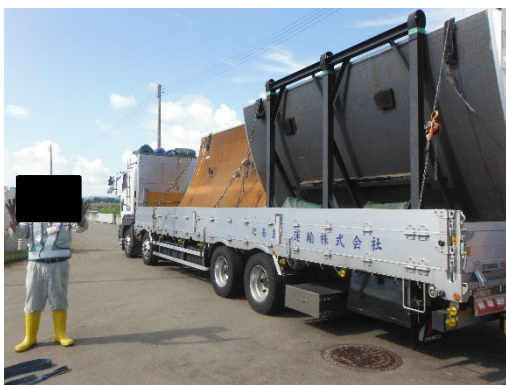
写真-6.5.7-1 インバート材搬入
