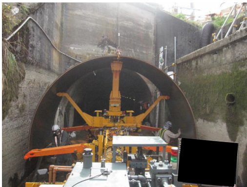
写真-6.5.7-7 クラウン材専用台車取付
