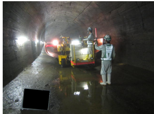
写真-6.5.7-4 インバート材坑内運搬
