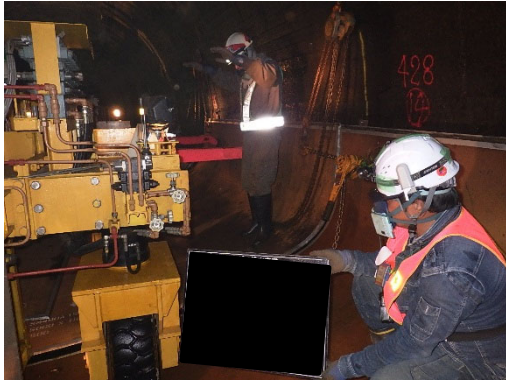
写真-6.5.7-5 インバート材据付
