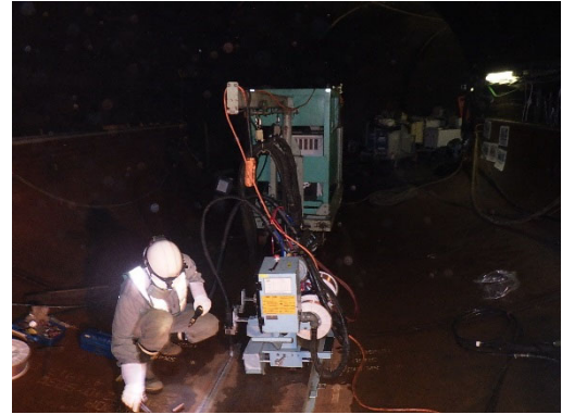
写真-6.5.7-6 インバート材溶接
