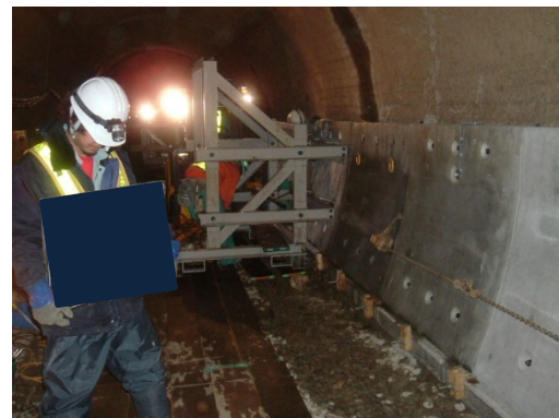
写真-8.5.7-14 側壁 PCL 版架設
