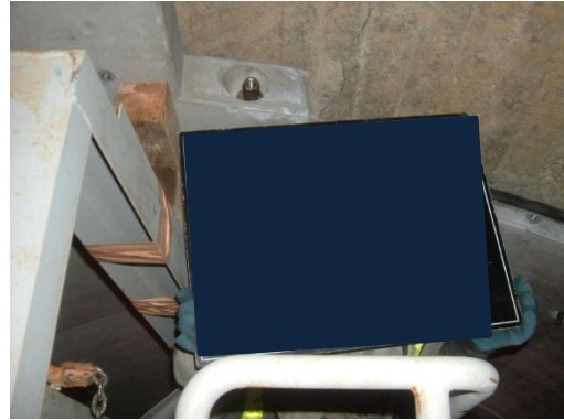
写真-8.5.7-22 連結ボルト締付完了
