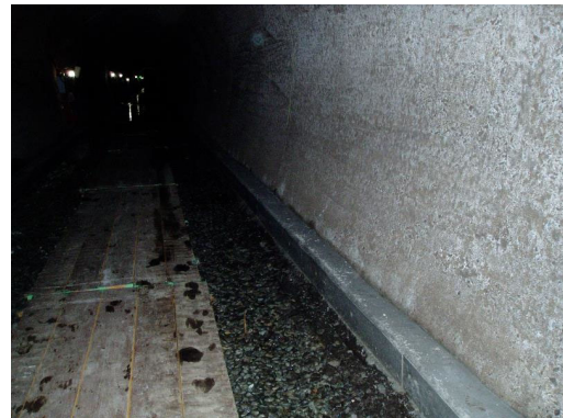
写真-8.5.7-11 基礎工（根固めコンクリート）
