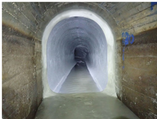
写真-8.5.7-3 端部（管口）仕上げ状況
