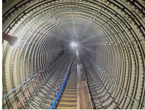
写真-8.5.7-5 鋼製リング組立状況
