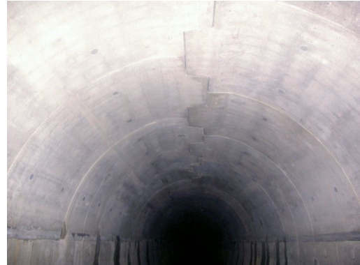
写真-8.5.7-24 PCL版組立完了
