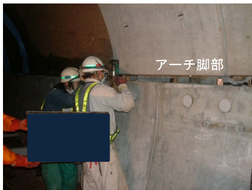
写真-8.5.7-19 PCL 版脚部高さ調整
