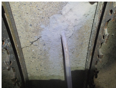
写真-8.5.7-4 湧水処理 (水路内への導水) (参考)
