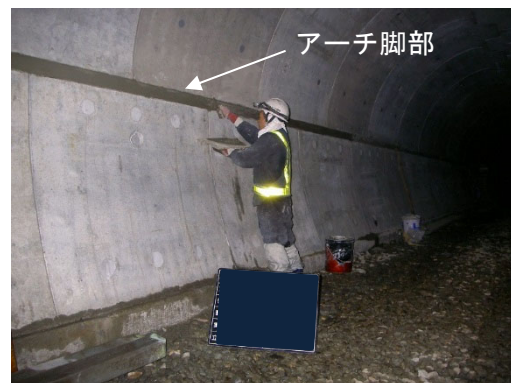
写真-8.5.7-20 PCL 版脚部固定
