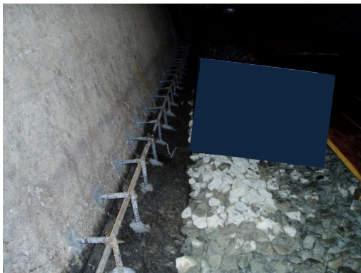
写真-8.5.7-10 鉄筋挿入・組み立て
