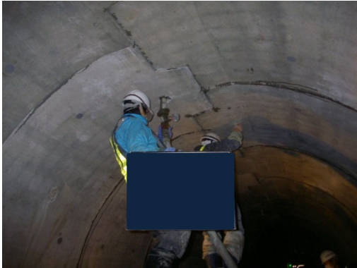
写真-8.5.7-23 裏込充填工
