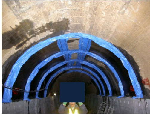
写真-8.5.7-12 湧水処理工の施工例
