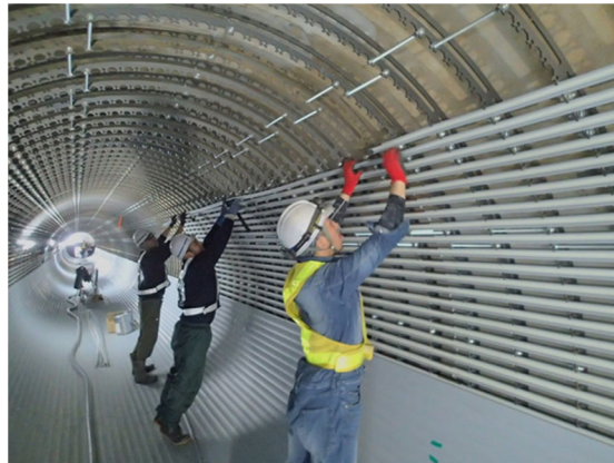
写真-8.5.7-6 嵌合部材、表面部材組付工の組付状況
