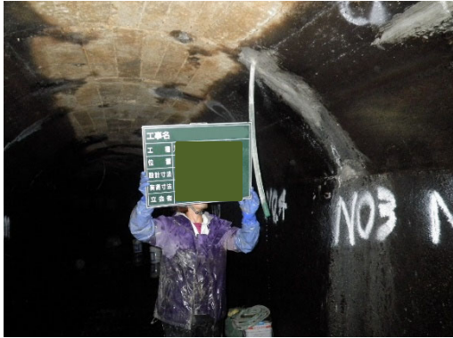
導水管設置時
