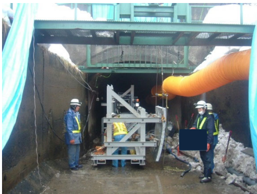
写真-8.5.7-13 側壁 PCL 版運搬
