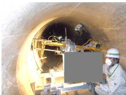
写真-10.1.1 ロックボルト打設
