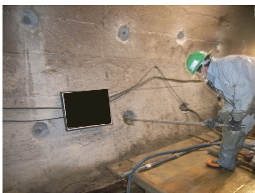
写真-10.5.7-3 ロックボルト挿入状況
