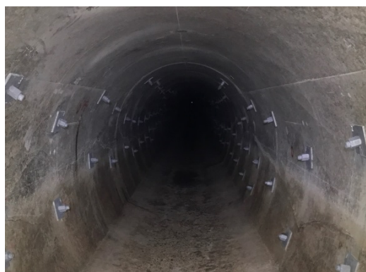
写真-10.1.2 ロックボルト施工後
