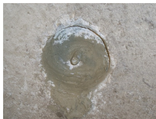
写真-10.5.7-4 ロックボルト挿入完了
