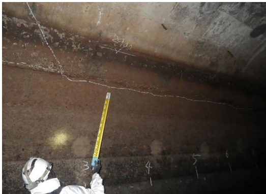
写真-10.2.2-1 S.L.付近の縦断方向ひび割れ
