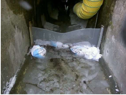
写真-4.6.3-1 浸入水の遮断
