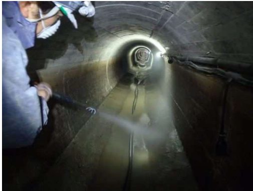
写真-4.6.4-1 高圧洗浄（インバート）
