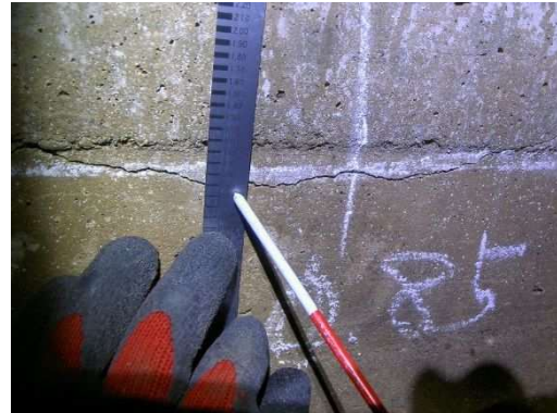
写真-4.6.3-4 ひび割れ幅測定
