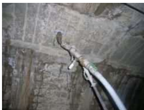
写真-5.4.7-4 可塑性材注入状況
