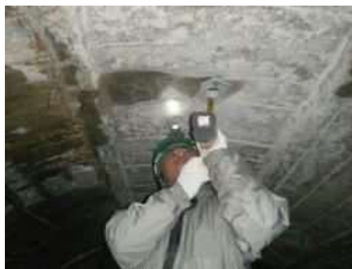
写真-5.4.7-2 注入管取付
