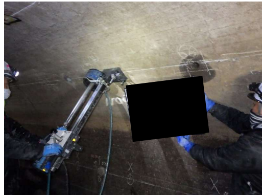
写真-5.1.2 注入孔削孔状況
