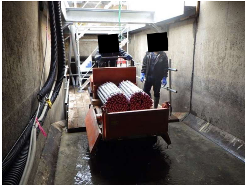
写真-5.1.1 資機材搬入
