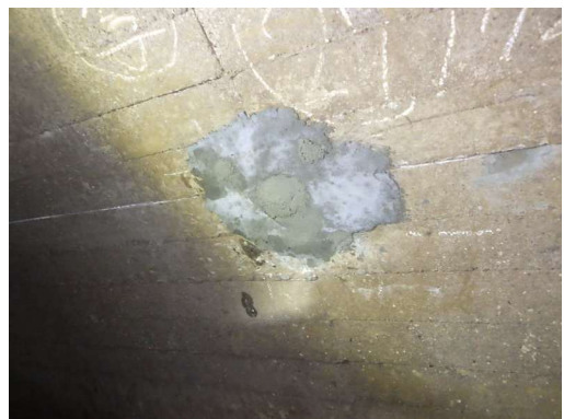
写真-5.1.4 目詰工・施工完了
