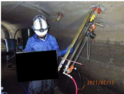
写真-5.1.3 グラウト注入状況
