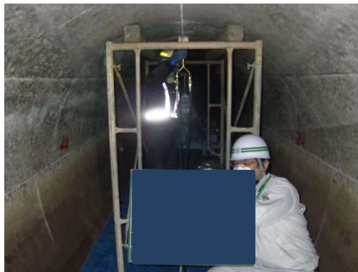
写真-5.3.3-1 仮補強工の施工状況
