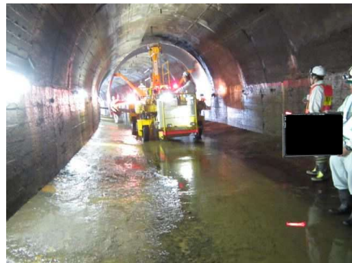
写真-6.5.7-8 クラウン材坑内運搬
