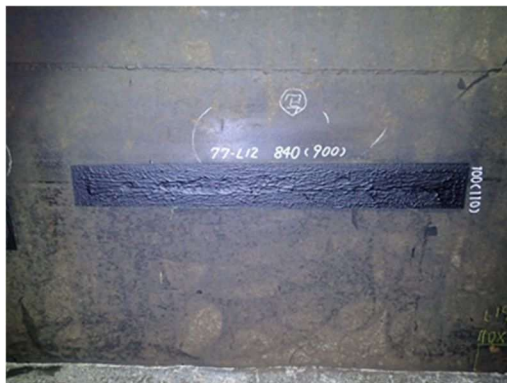
写真-6.7.2-1 水路トンネルにおける塗装補修の事例
