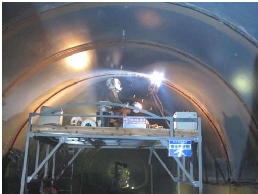
写真-6.5.7-9 クラウン材溶接
