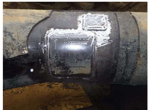
写真-6.7.2-2 当て板補修の事例(鋼管外面)
