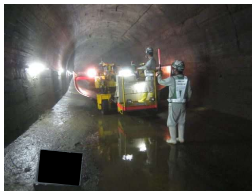
写真-6.5.7-4 インバート材坑内運搬
