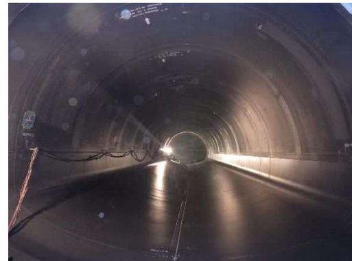
写真-6.5.7-10 施工完了
