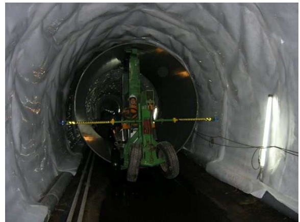
写真-7.4.4-1 止水・導水対策事例
