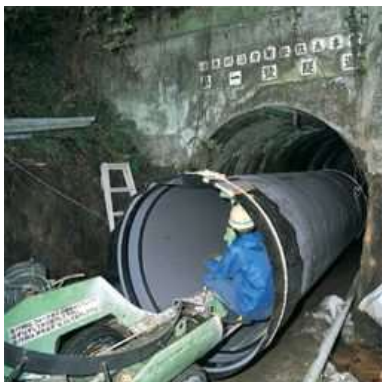
写真-7.1.1 円形 FRPM 管挿入工法
