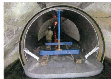
図-7.5.7-11 フローティング方式の FRPM 管挿入工法
