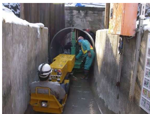
写真-7.1.2 馬てい形 FRPM 管挿入工法
