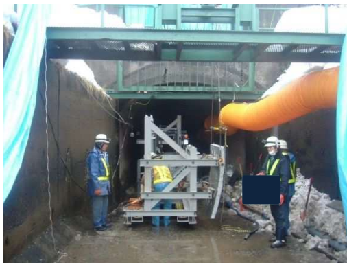
写真-8.5.7-13 側壁 PCL 版運搬
