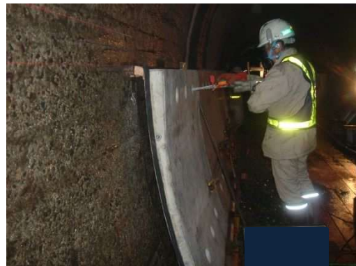
写真-8.5.7-18 側壁部アンカー工
