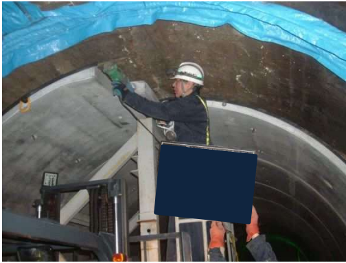
写真-8.5.7-21 連結ボルト締め付け
