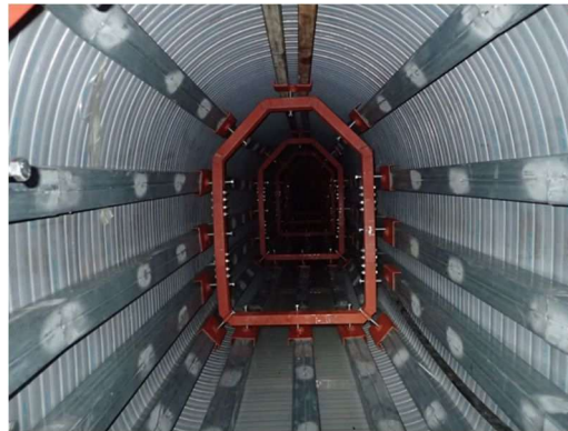
写真-8.5.7-2 支保材設置状況（例）
