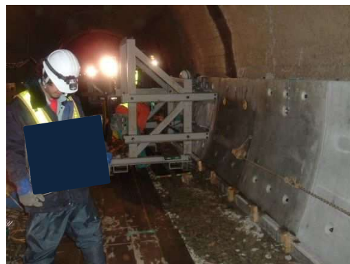
写真-8.5.7-14 側壁 PCL 版架設
