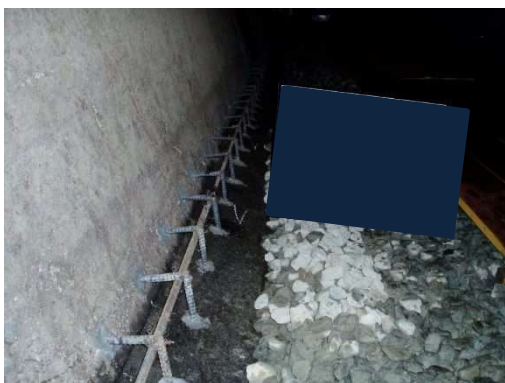
写真-8.5.7-10 鉄筋挿入・組み立て
