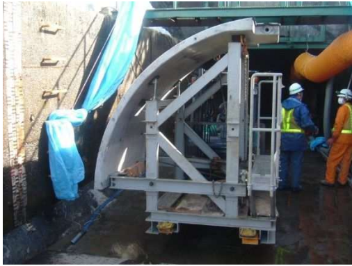
写真-8.5.7-15 アーチ PCL 版運搬
