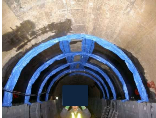
写真-8.5.7-12 湧水処理工の施工例
