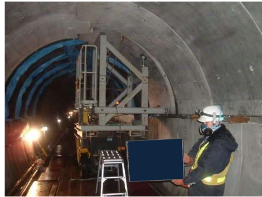
写真-8.5.7-16 アーチ PCL 版架設
