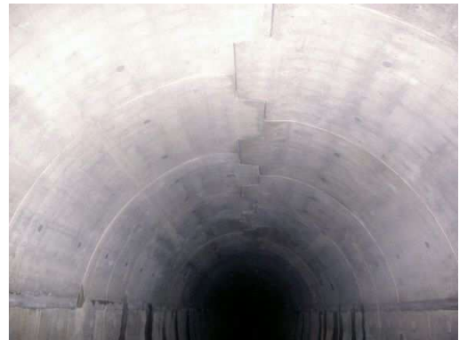
写真-8.5.7-24 PCL版組立完了
