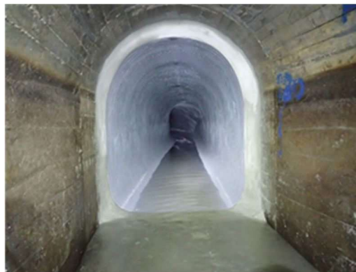
写真-8.5.7-3 端部（管口）仕上げ状況
