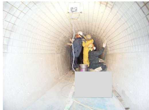
ポリマーセメントモルタルコテ塗り
