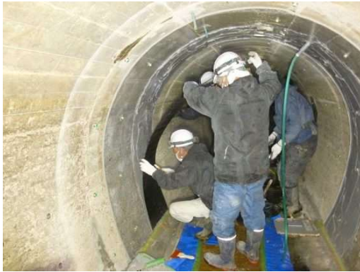
繊維シート設置
