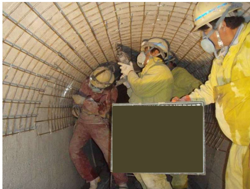
補強鉄筋組立（アンカー打設）
