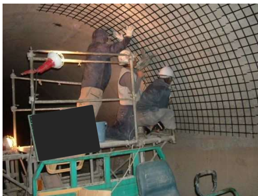
繊維グリッド取付（アンカー打設）
