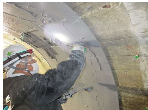
写真-9.5.7-8 増厚工(樹脂モルタル)
