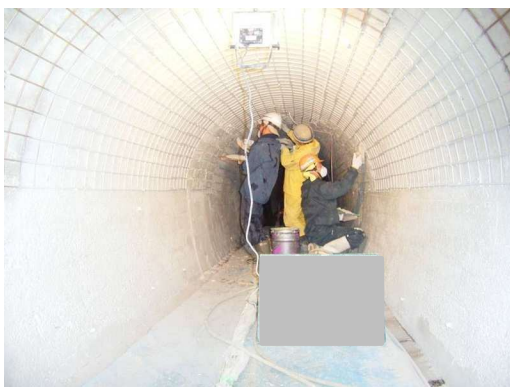
写真-9.5.7-11 コテ仕上げ
