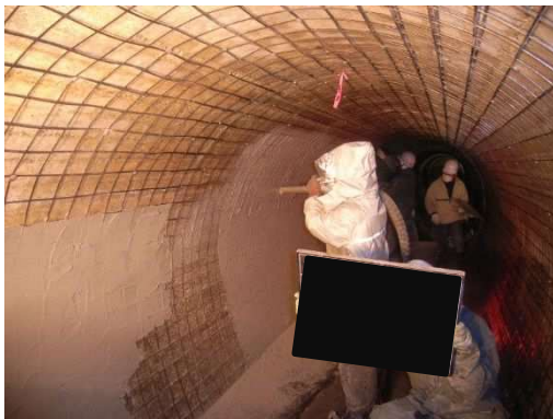
写真-9.5.7-3 増厚材吹付け
