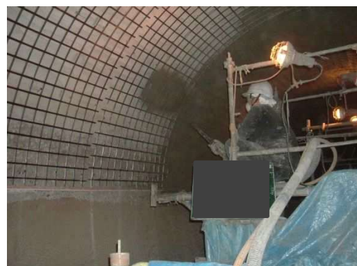
ポリマーセメントモルタル吹付け
