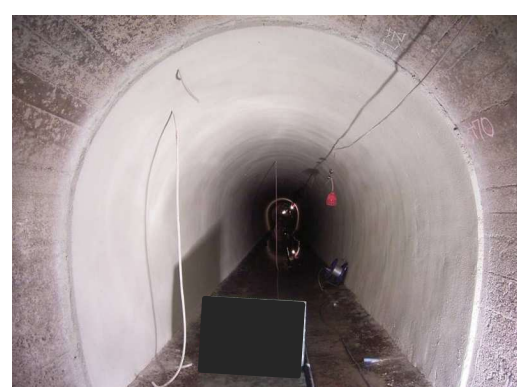
写真-9.5.7-12 完了状況
