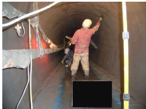
写真-9.5.7-4 コテ仕上げ
