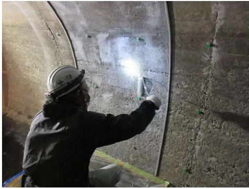
写真-9.5.7-5 プライマー工
