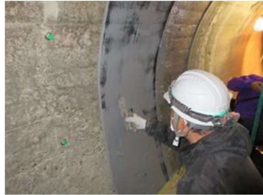
樹脂モルタルコテ塗り（上塗り）
