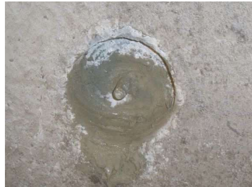
写真-10.5.7-4 ロックボルト挿入完了
