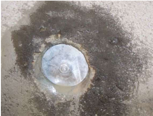
写真-10.5.7-5 ベアリングプレート・ナット
