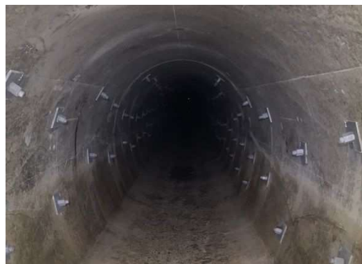
写真-10.1.2 ロックボルト施工後
