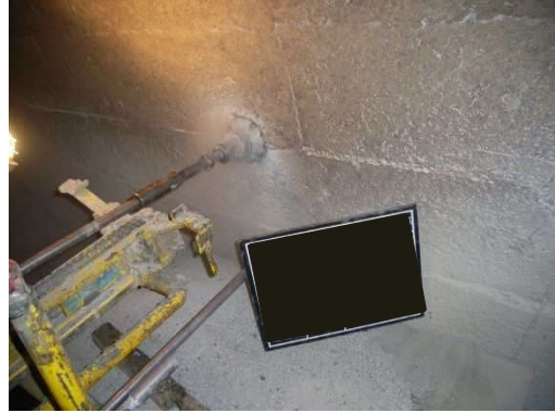
写真-10.5.7-2 拡径状況
