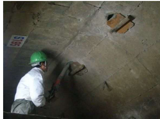
写真-10.5.7-6 頭部処理状況
