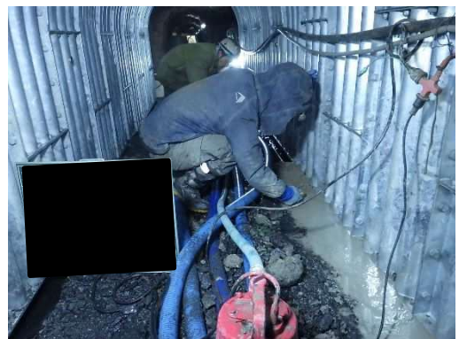
写真-11.5.4-12 ベース材取付部埋戻(PCM)
