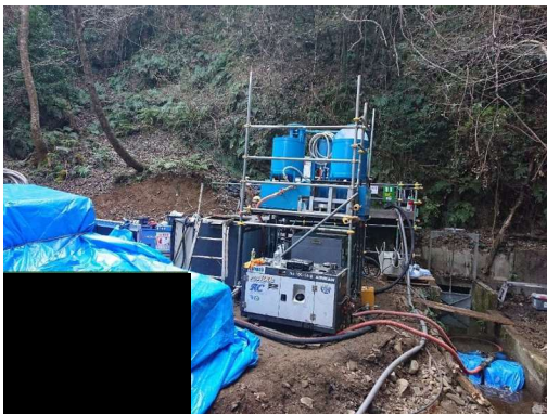
写真-11.5.4-29 可塑性注入材注入プラント設置
