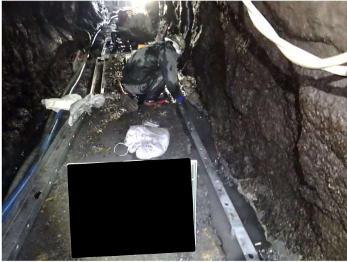
写真-11.5.4-7 ベース材（溝形鋼）設置
