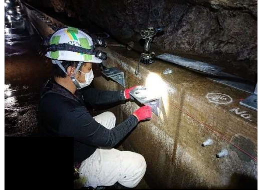
写真-11.5.4-26 ベース材設置
