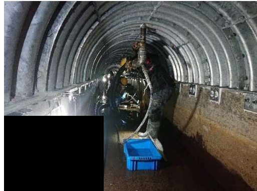
写真-11.5.4-32 可塑性注入材注入状況
