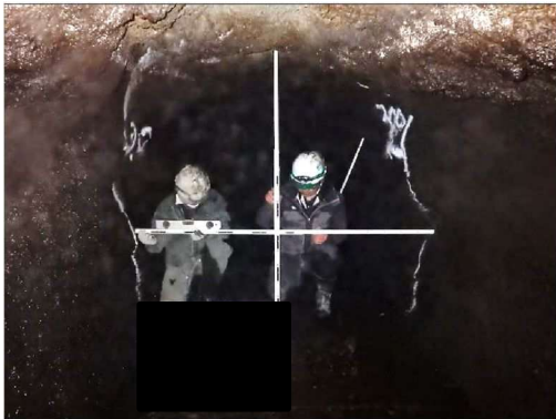
写真-11.5.4-3 断面測定
