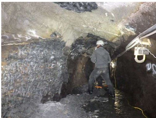
写真-11.5.4-5 地山掘削
