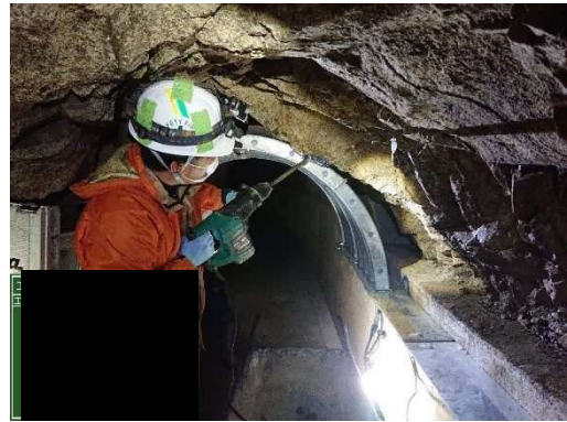
写真-11.5.4-22 人力岩掘削
