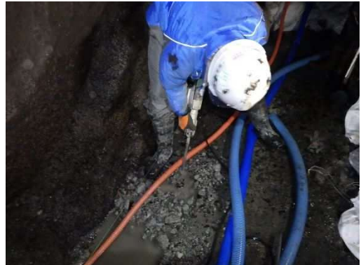
写真-11.5.4-4 インバート取壊し
