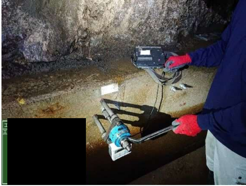
写真-11.5.4-25 アンカーボルト引抜試験
