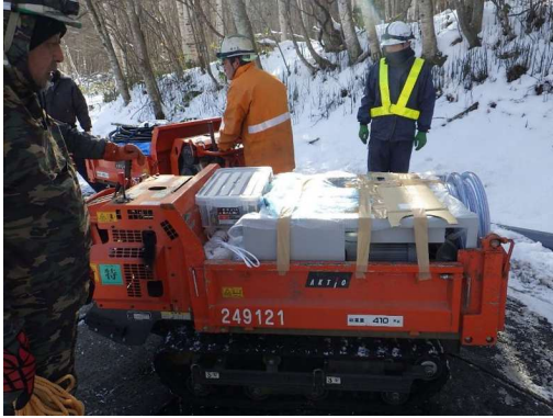
写真-11.5.4-13 裏込充填機材搬入
