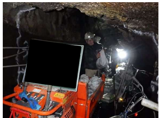
写真-11.5.4-6 殻集積・運搬・搬出
