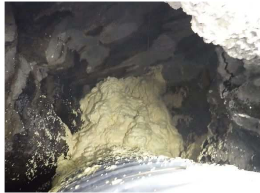
写真-11.5.4-16 発泡ウレタン注入状況
