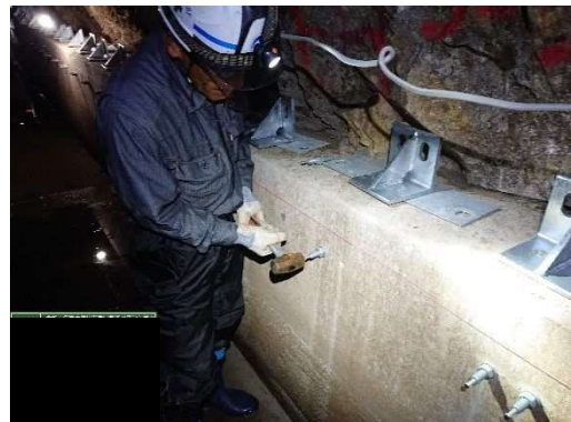
写真-11.5.4-24 アンカーボルト設置
