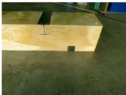
写真-2.2.4 充填確認状況 (2)
