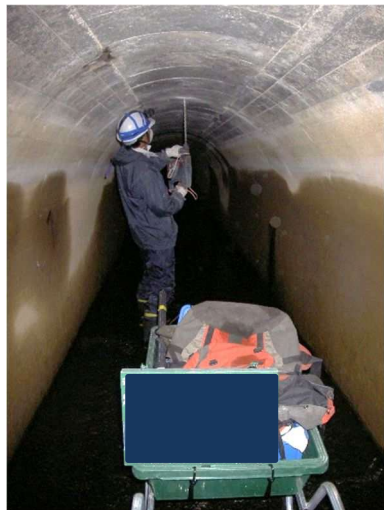
写真-1.6 覆工削孔状況
