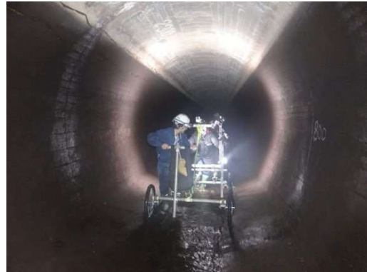
(2) 坑内調査状況 (前面)
