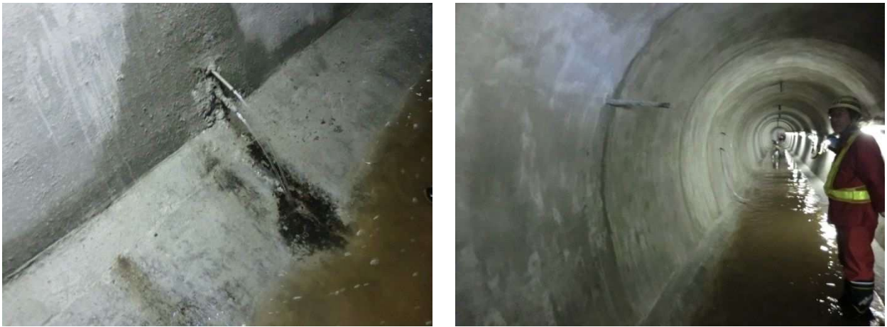
写真-4.6.5-1 接着工法に適用された導水対策工（流末処理）の事例
