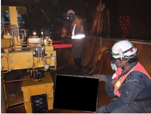
写真-6.5.7-5 インバート材据付
