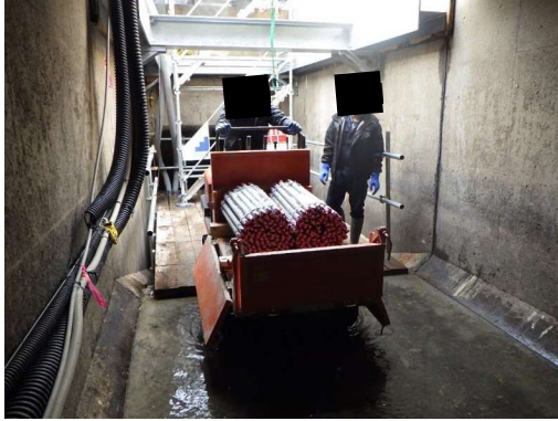
写真-5.1.1 資機材搬入
