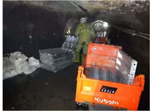
写真-11.5.4-8 ライナープレート運搬・搬入
