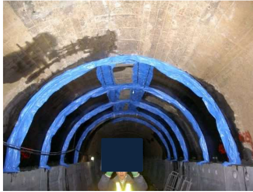
写真-8.5.7-12 湧水処理工の施工例
