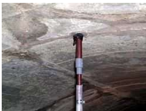
写真-5.4.7-5 注入管取付状況
