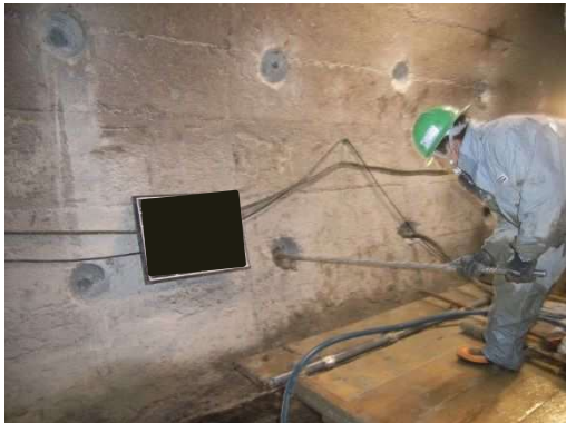
写真-10.5.7-3 ロックボルト挿入状況
