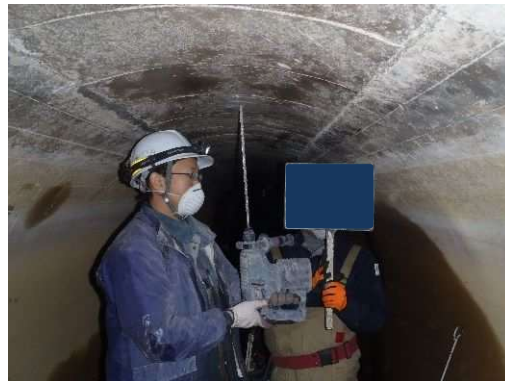
写真-1.5 検証用削孔状況
