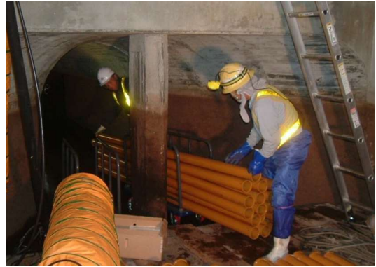
写真-4.6.3-7 坑内運搬状況（人力運搬）
