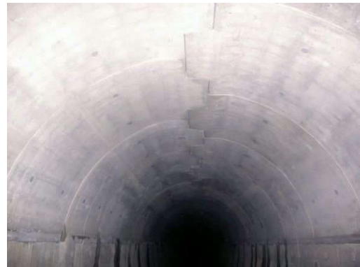
写真-8.5.7-24 PCL版組立完了
