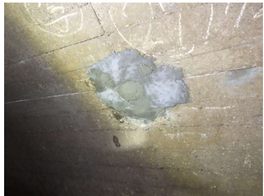
写真-5.1.4 目詰工・施工完了
