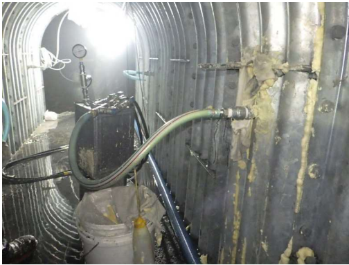
写真-11.5.4-15 裏込充填材注入状況
