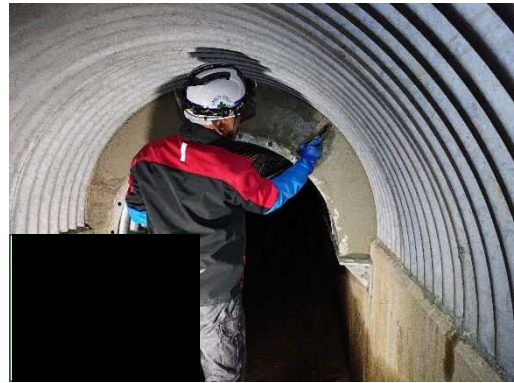
写真-11.5.4-34 端部（管口）仕上げ状況 （モルタル仕上）
