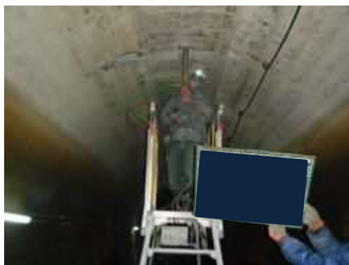
写真-5.4.7-1 注入孔削孔
