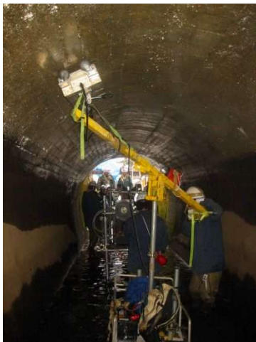
写真-1.3 調査状況（全景）
