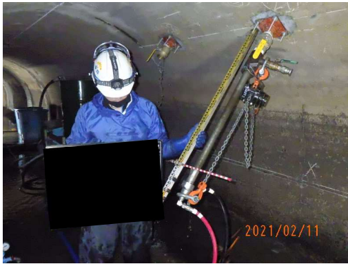
写真-5.1.3 グラウト注入状況
