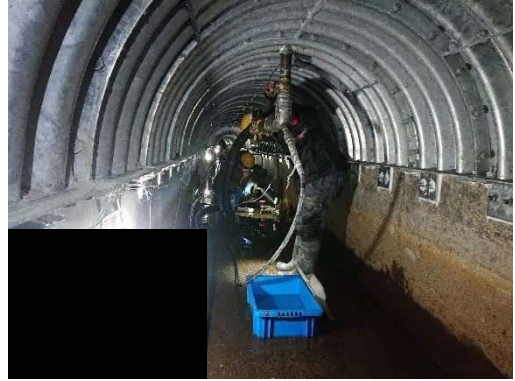
写真-11.5.4-32 可塑性注入材注入状況
