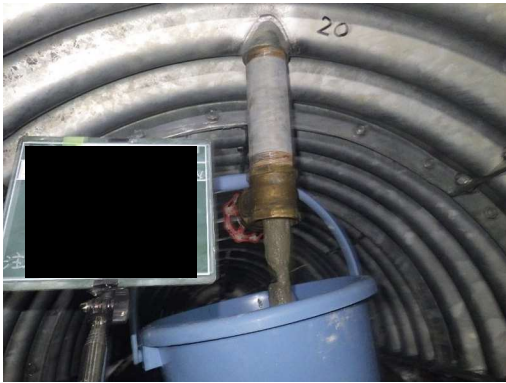
写真-11.5.4-33 可塑性注入材リーク確認
