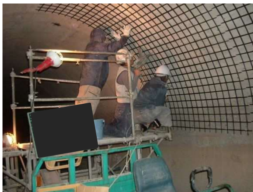
繊維グリッド取付（アンカー打設）
