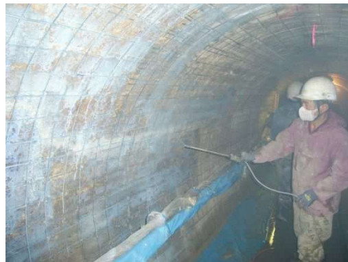
写真-9.5.7-2 プライマーエ
