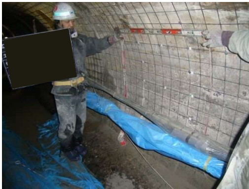
写真-9.5.7-1 繊維グリッド取付
