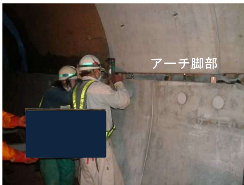
写真-8.5.7-19 PCL 版脚部高さ調整
