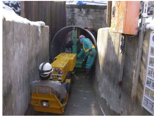
写真-7.1.2 馬てい形 FRPM 管挿入工法
