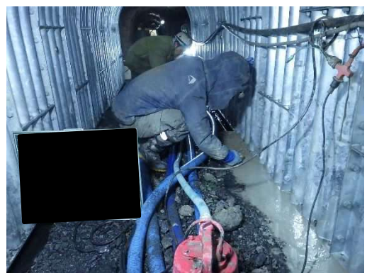
写真-11.5.4-12 ベース材取付部埋戻（PCM）
