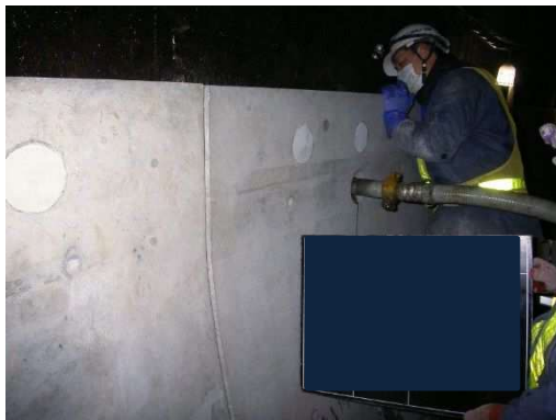
写真-8.5.7-17 側壁部裏込充填材注入
