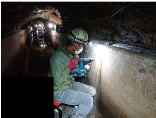
写真-11.5.4-23 アンカーボルト削孔
