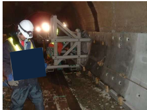
写真-8.5.7-14 側壁 PCL 版架設
