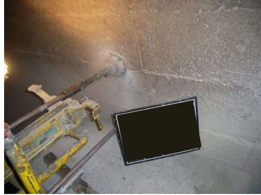
写真-10.5.7-2 拡径状況
