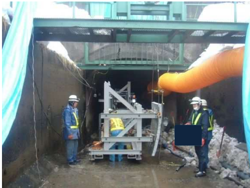
写真-8.5.7-13 側壁 PCL 版運搬
