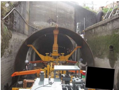
写真-6.5.7-7 クラウン材専用台車取付
