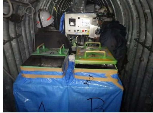
写真-11.5.4-14 裏込充填機材（発泡ウレタン）
