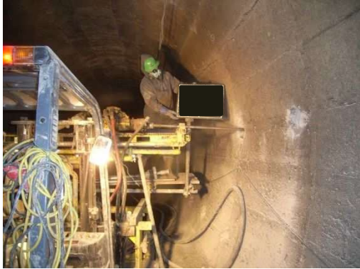
写真-10.5.7-1 穿孔状況
