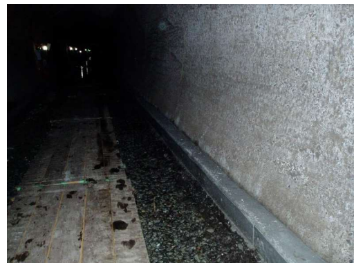
写真-8.5.7-11 基礎工（根固めコンクリート）
