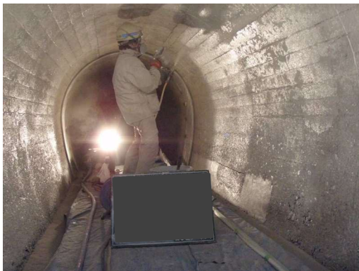
写真-9.5.7-9 プライマー工
