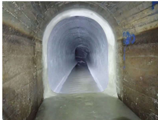
写真-8.5.7-3 端部（管口）仕上げ状況
