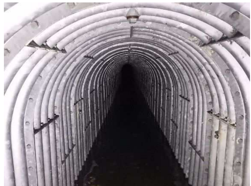
写真-11.5.4-18 施工完了
