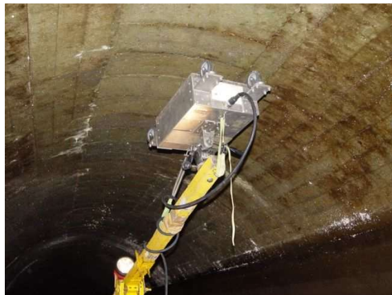
写真-1.4 調査状況（アンテナ部）
