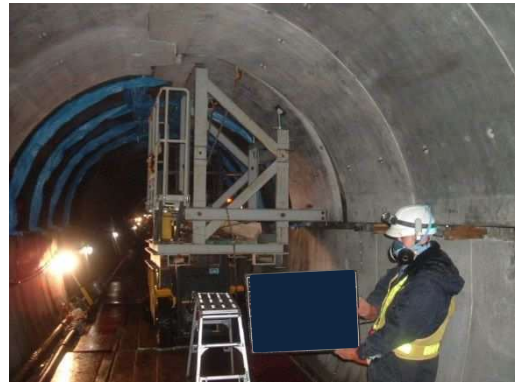
写真-8.5.7-16 アーチ PCL 版架設
