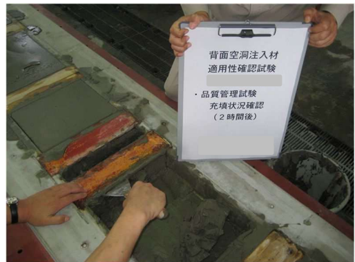
写真-3.1.2-2 充填確認状況
