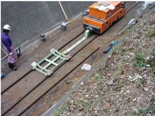
写真-4.6.3-5 坑内運搬状況（レール方式（軌道式））
