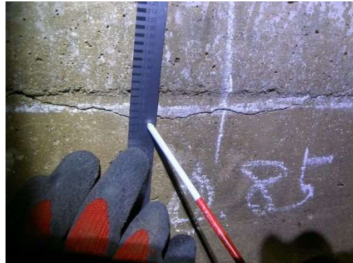
写真-4.6.3-4 ひび割れ幅測定
