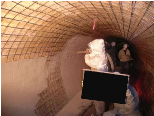
写真-9.5.7-3 増厚材吹付け
