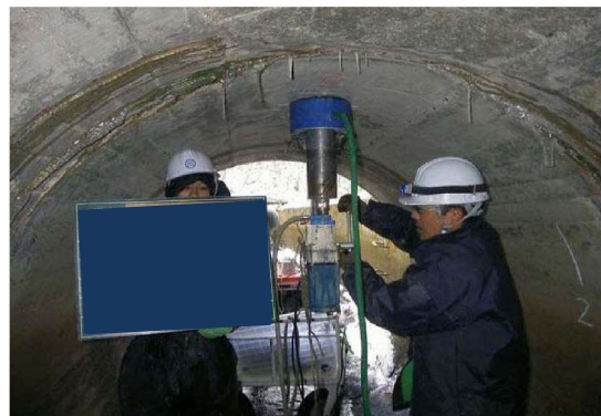
写真-1.2 簡易ボーリング機による削孔作業
