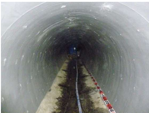
写真-9.5.7-9 完了状況
