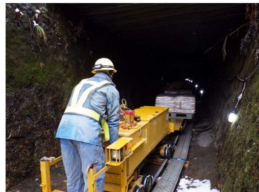
写真-4.6.3-5 坑内運搬状況（レール方式（軌道式））
