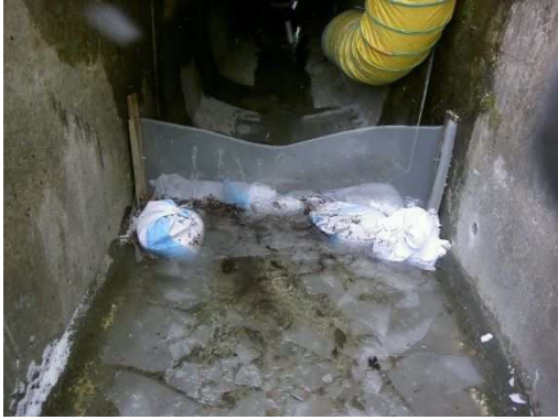
写真-4.6.3-1 浸入水の遮断
