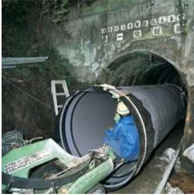
写真-7.1.1 円形 FRPM 管挿入工法
