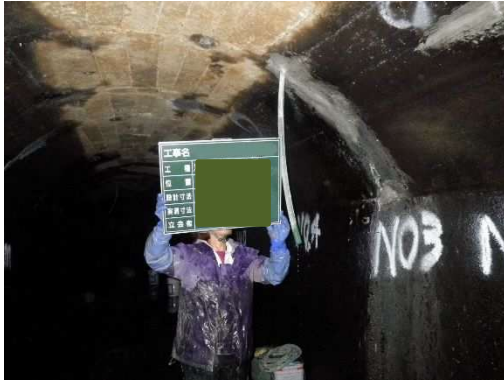
導水管設置時
