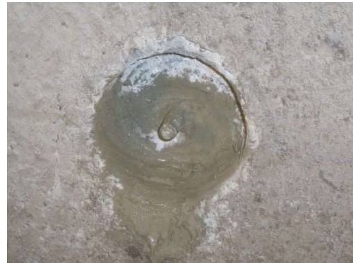
写真-10.5.7-4 ロックボルト挿入完了
