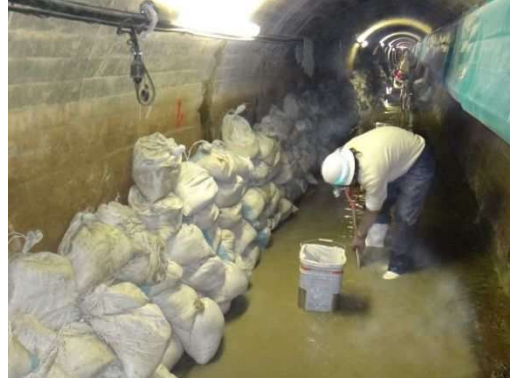
写真-4.6.3-2 水路トンネルインバートの清掃
