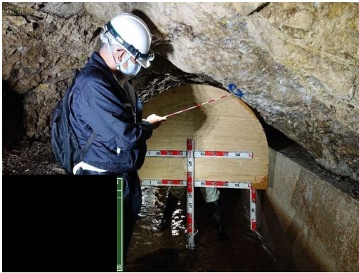
写真-11.5.4-21 断面測定
