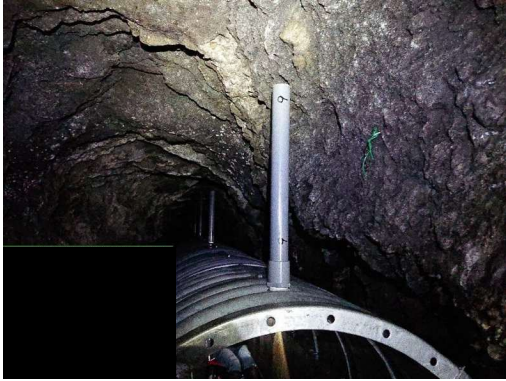
写真-11.5.4-31 可塑性注入材注入管取付
