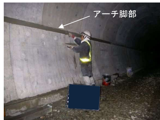
写真-8.5.7-20 PCL 版脚部固定
