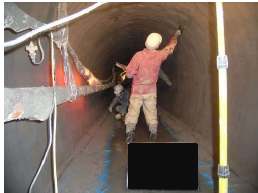
写真-9.5.7-4 コテ仕上げ
