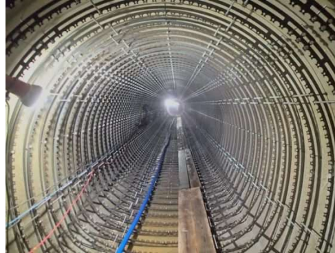
写真-8.5.7-5 鋼製リング組立状況
