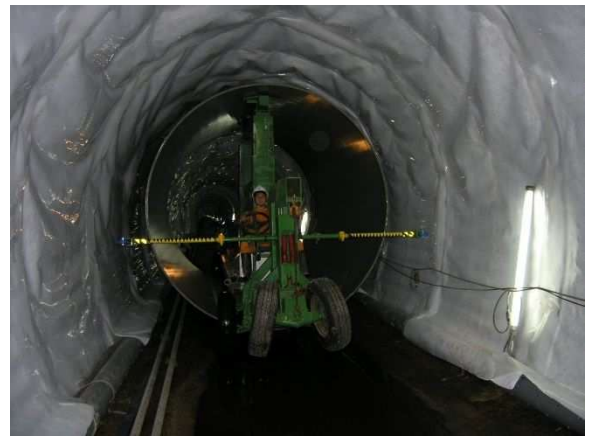
写真-7.4.4-1 止水・導水対策事例
