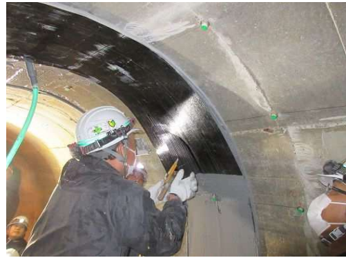
写真-9.5.7-6 繊維シート設置
