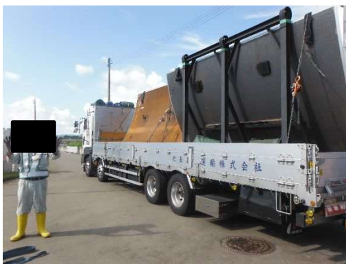
写真-6.5.7-1 インバート材搬入
