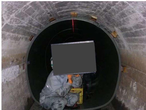
写真-7.5.7-2 浮上防止材設置状況
