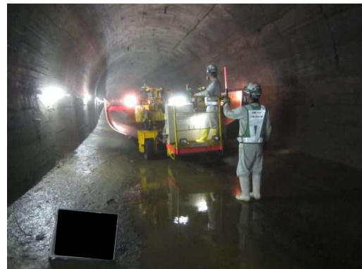
写真-6.5.7-4 インバート材坑内運搬
