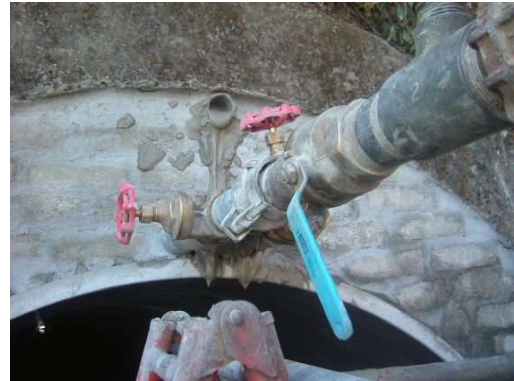
写真-7.5.7-5 空気抜き管によるリーク確認
