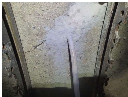
写真-8.5.7-4 湧水処理 (水路内への導水) (参考)
