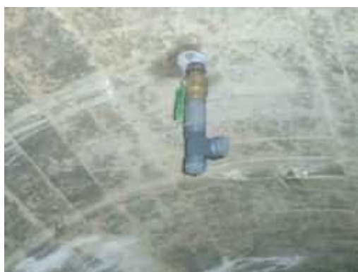
写真-5.4.7-3 ストップバルブ設置状況
