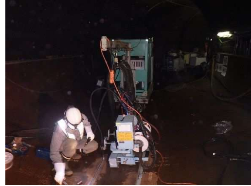
写真-6.5.7-6 インバート材溶接
