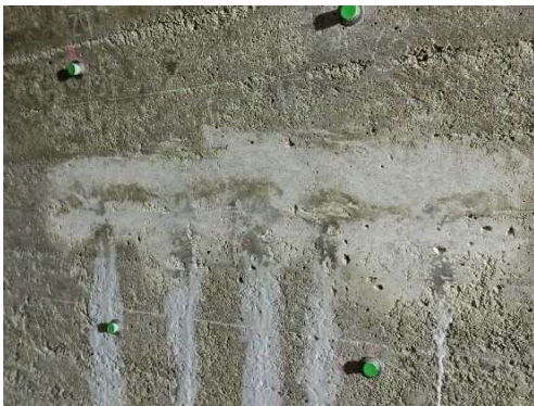
写真-9.5.7-7 通水型アンカー設置
