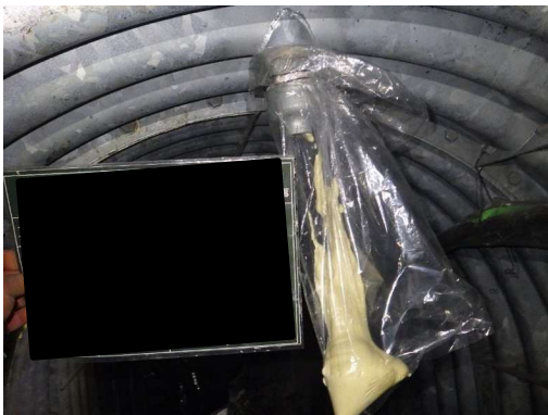
写真-11.5.4-17 裏込充填材注入完了
