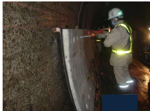
写真-8.5.7-18 側壁部アンカー工
