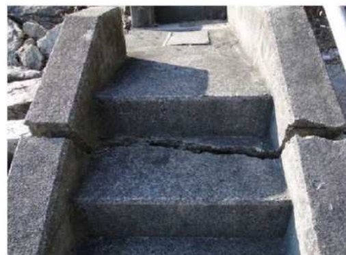
⑧堤体上下流斜面階段工の状況
