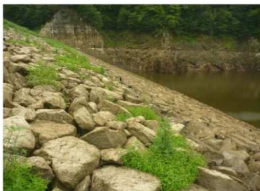
⑦堤体上下流斜面の状況
