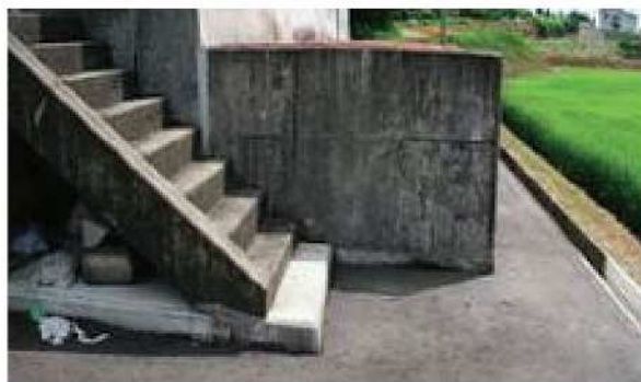
調圧水槽復旧完了
