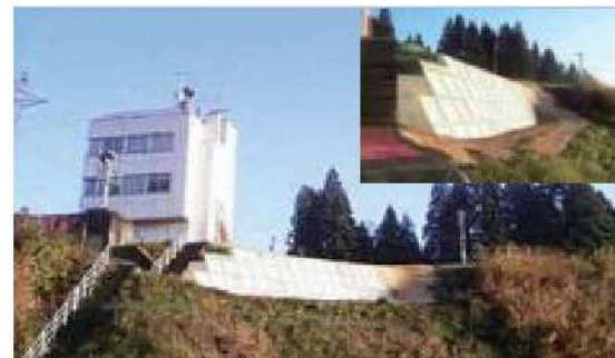
管理棟復旧完了
