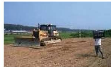
ストックヤードでの盛土試験状況
