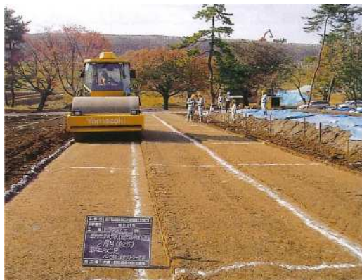
試験盛立状況写真
