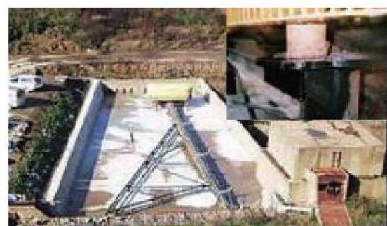
取水施設復旧完了
