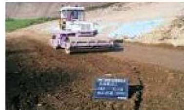
堤体盛土状況 (11t級振動ローラー)
