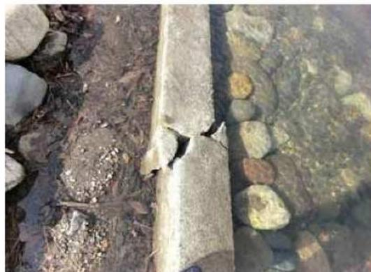
③法止コンクリートのクラック・変形
