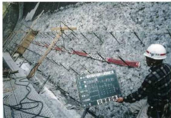
写真-巻-31 アンカー打設完了
