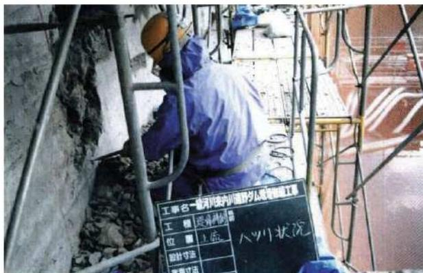
写真-巻-9 補修部ハツリ処理
