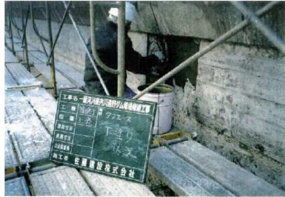
写真-巻-20 補修材下塗り（タフエース）
