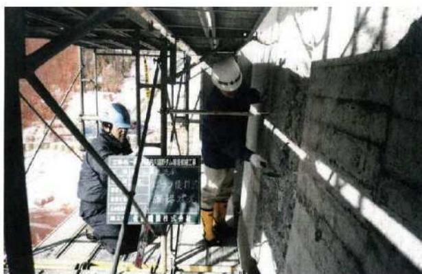
写真-巻-12 劣化部除去完了検査
