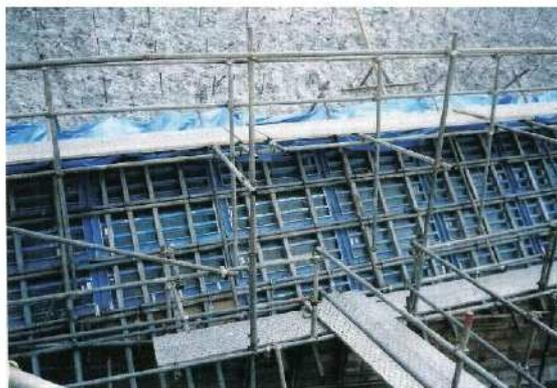
写真-巻-34 型枠設置完了
