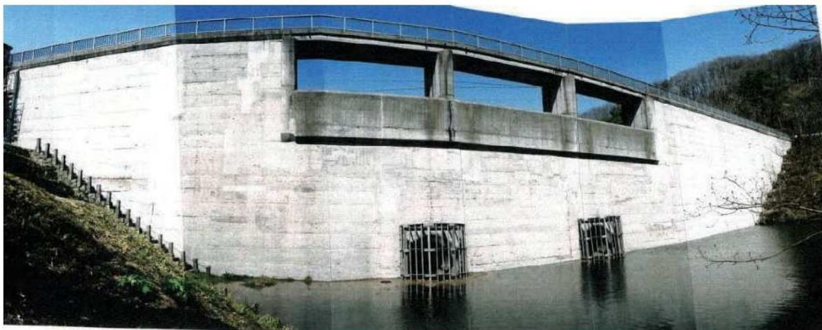
写真-巻-24 堤体上流面補修完了
