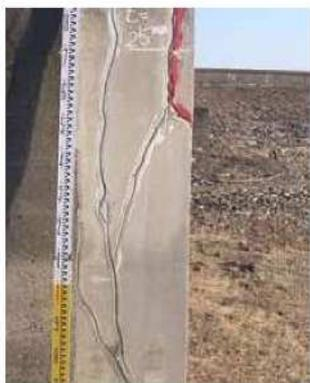
④洪水吐導流壁部のクラック
