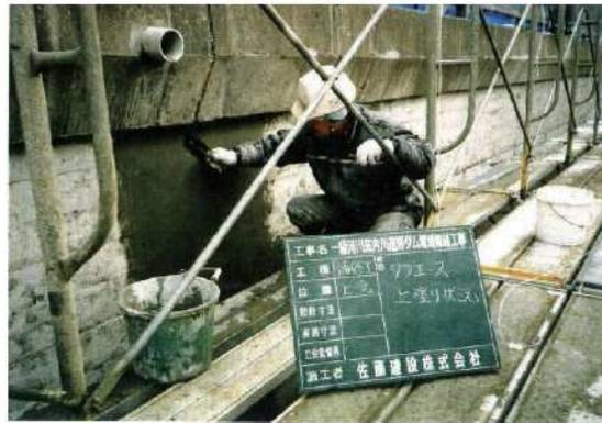
写真-巻-21 補修材上塗り（タフエース）
