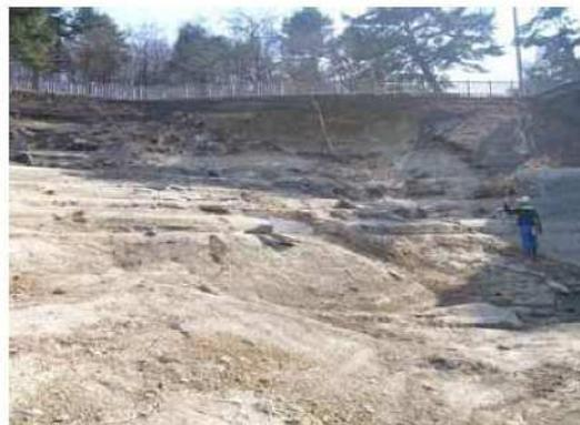
⑦右岸法面保護工部の崩落
