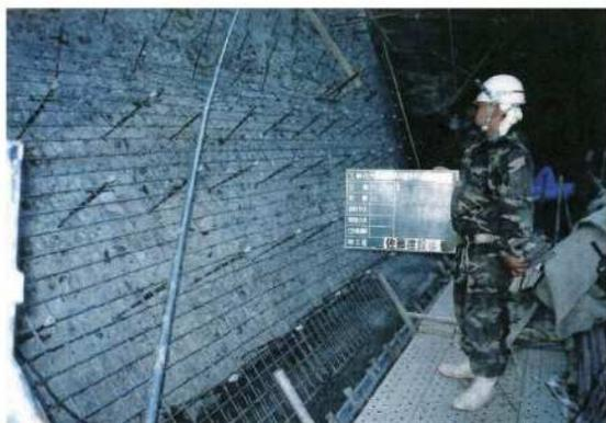
写真-巻-32 溶接金網設置完了
