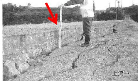
写真-1 浅河原調整池の段差地形
