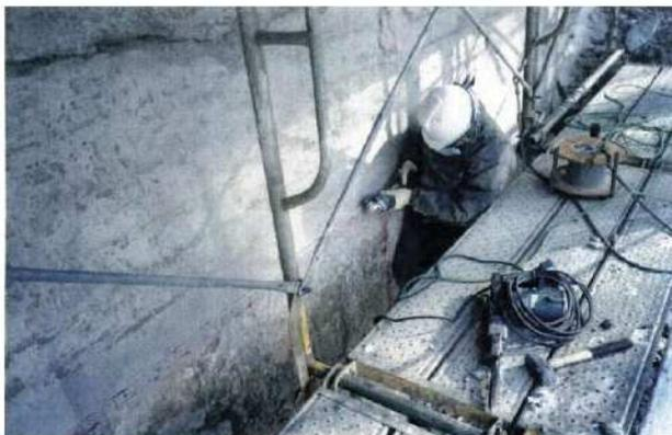
写真-巻-8 補修部カッター処理
