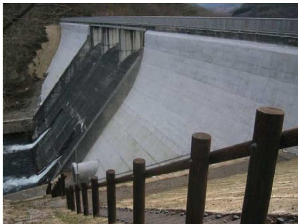
写真-巻-41 堤体下流面補修完了（左岸から）
