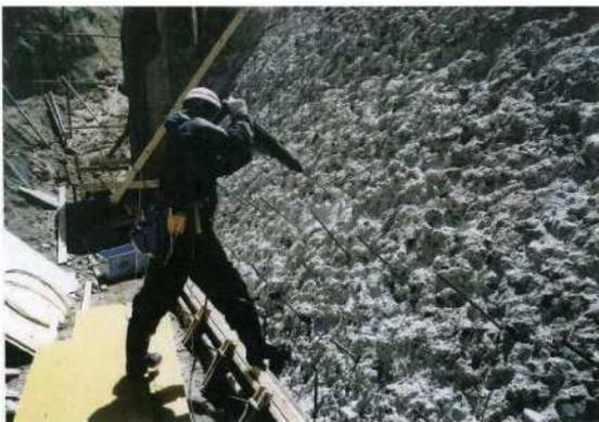
写真-巻-30 アンカー打設（削孔）
