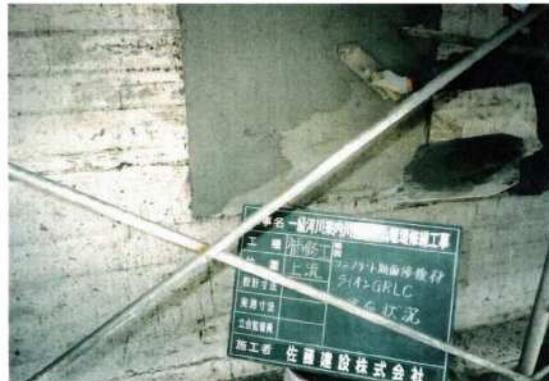
写真-巻-18 補修材上塗り
