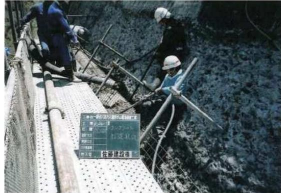
写真-巻-37 コンクリート打設状況
