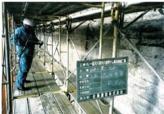
写真-巻-11 補修部洗浄状況
