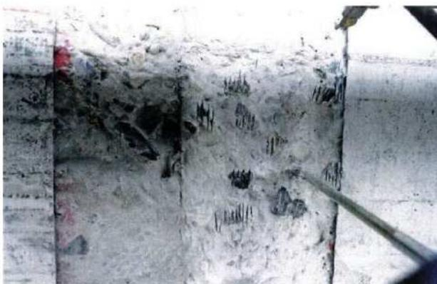
写真-巻-10 補修部骨材カッター処理
