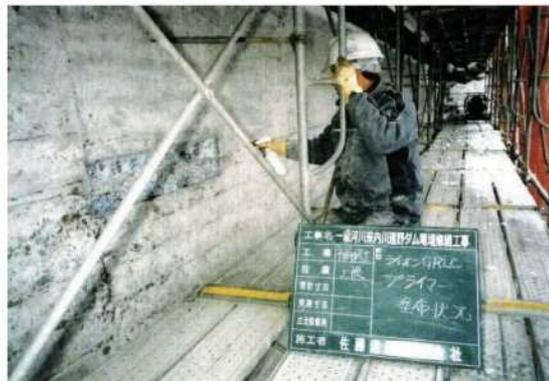
写真-巻-16 補修部プライマー処理
