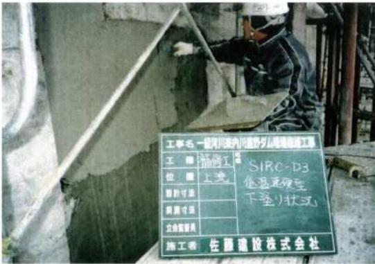
写真-巻-13 補修材下塗り（SIRC-D3）
