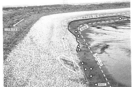
写真-12 堆泥によるドレーン前面閉塞状況(新山本調整池)
