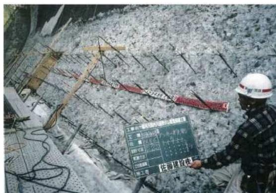
写真-巻-31 アンカー打設完了
