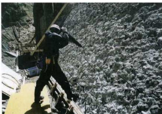
写真-巻-30 アンカー打設（削孔）
