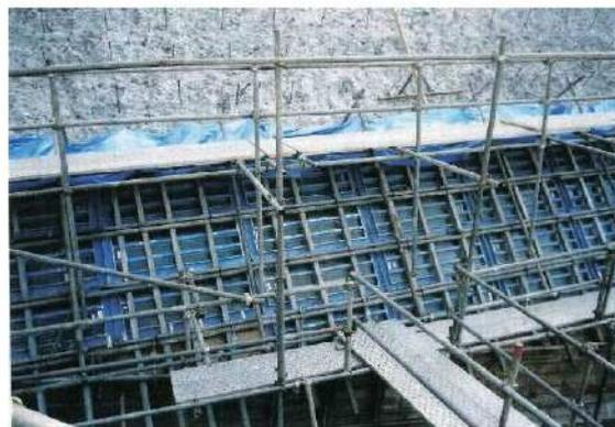
写真-巻-34 型枠設置完了
