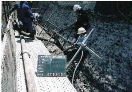
写真-巻-37 コンクリート打設状況
