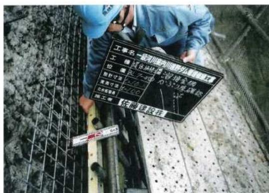
写真-巻-33 溶接金網かぶり確認
