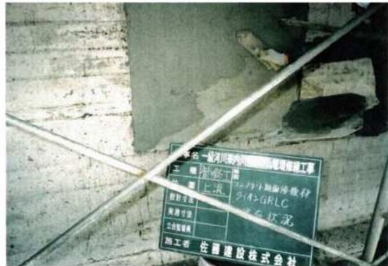
写真-巻-18 補修材上塗り
