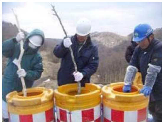
写真-5.2-3 石灰水を攪拌している状況
