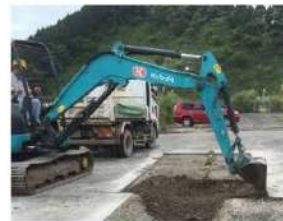
③ アスファルトの撤去・掘削
