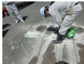
② アスファルト上の開口亀裂・目地に充填材を投入
