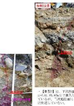
・【亀裂2】は、下流斜面の4号土、8.5~6mまで貫入しているが、下流斜面には到達していない。
