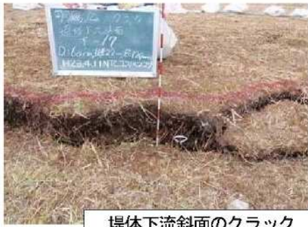
堤体下流斜面のクラック
