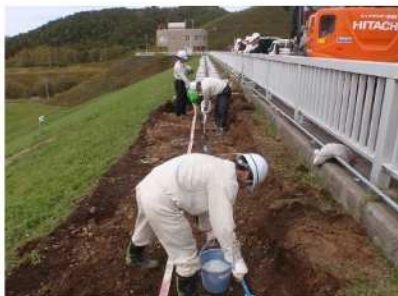
④40cm掘削面のクラック部に石灰水注入80L
