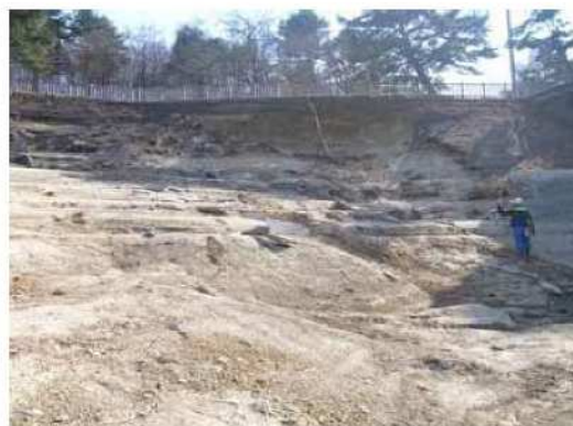
⑦右岸法面保護工部の崩落
