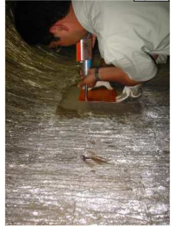
●テストハンマー(シュミットハンマー)の実施例 (打撃面は石などで研磨し平滑にする)： 写真は監査廊内での試験状況
