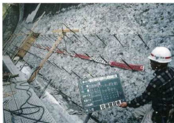
写真-巻-31 アンカー打設完了
