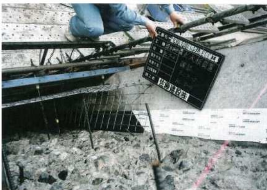
写真-巻-35 目地部処理完了
