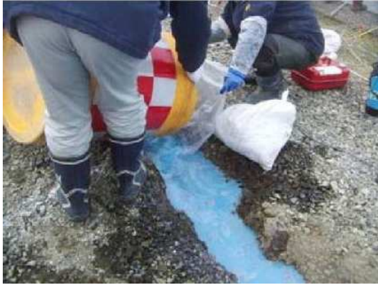
写真-5.2-4 石灰水注入状況（着色料混入）
