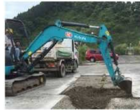
③ アスファルトの撤去・掘削
