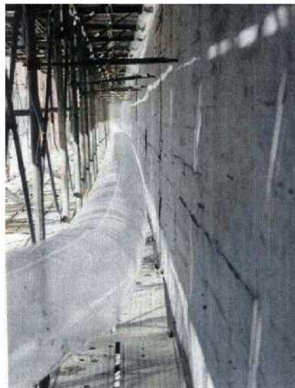
写真-巻-22 養生（ビニールダクト）
