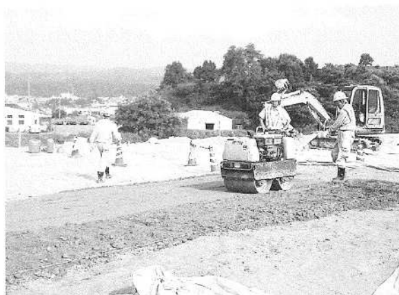
写真-4 人力施工 (浅河原調整池)
