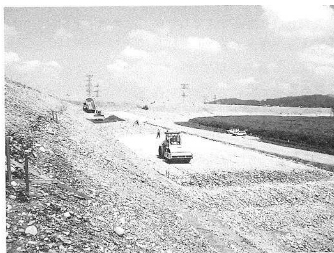
写真－14 ドレーン材転圧状況（新山本調整池）
