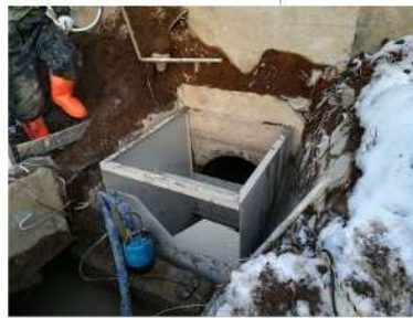
② 応急施設設置、モルタル埋戻し
