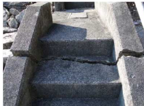
⑧堤体上下流斜面階段工の状況
