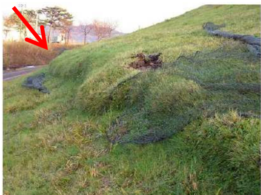
写真-5.1-8 下流法面のはらみ出し (山本第二調整池※参考) : 右図写真-10
