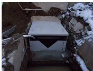
⑤ 応急施設設置完了 (保護蓋設置)
