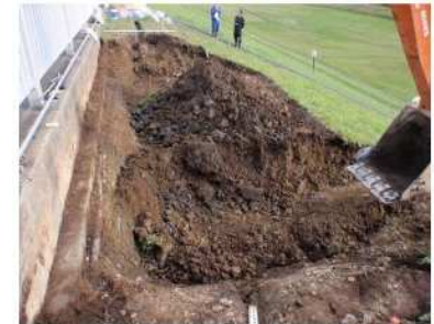
半透水性材料の透率は高く(施工時の盛立管理試験結果では80%) マトリックスは比較的緻密、ブロックサンプリングは困難な印象
