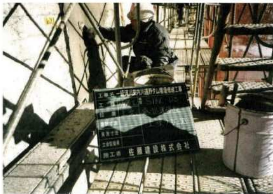
写真-巻-15 補修材上塗り（SIRC-D3）
