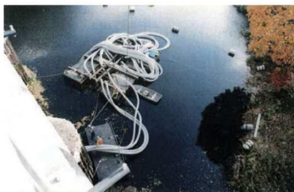
写真-巻-3 水替え状況
