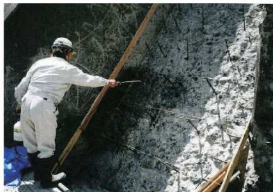
写真-巻-36 コンクリート改質剤塗布
