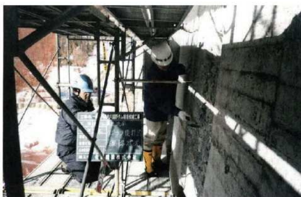
写真-巻-12 劣化部除去完了検査
