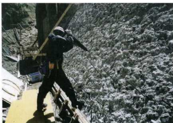
写真-巻-30 アンカー打設（削孔）
