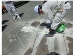
② アスファルト上の開口亀裂・目地に充填材を投入
