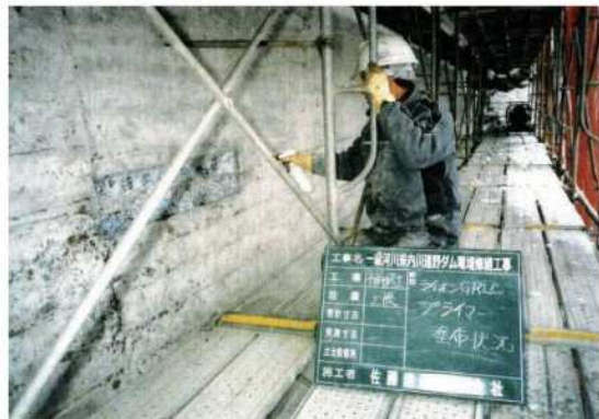
写真-巻-16 補修部プライマー処理 （ライオン GRLC）
