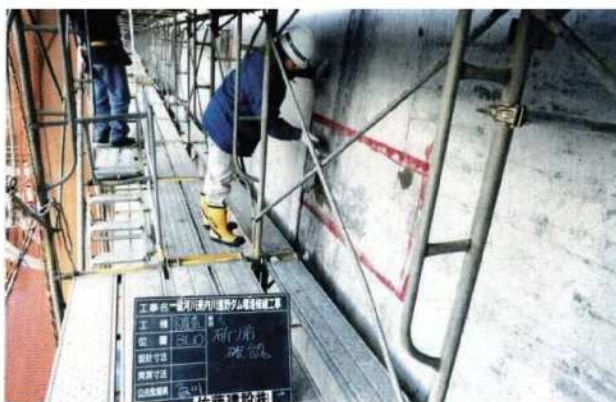
写真-巻-6 補修部検査
