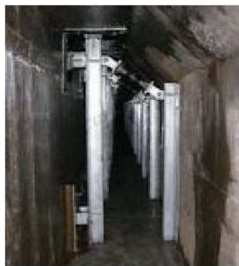
仮排水トンネル通廊復旧完了
