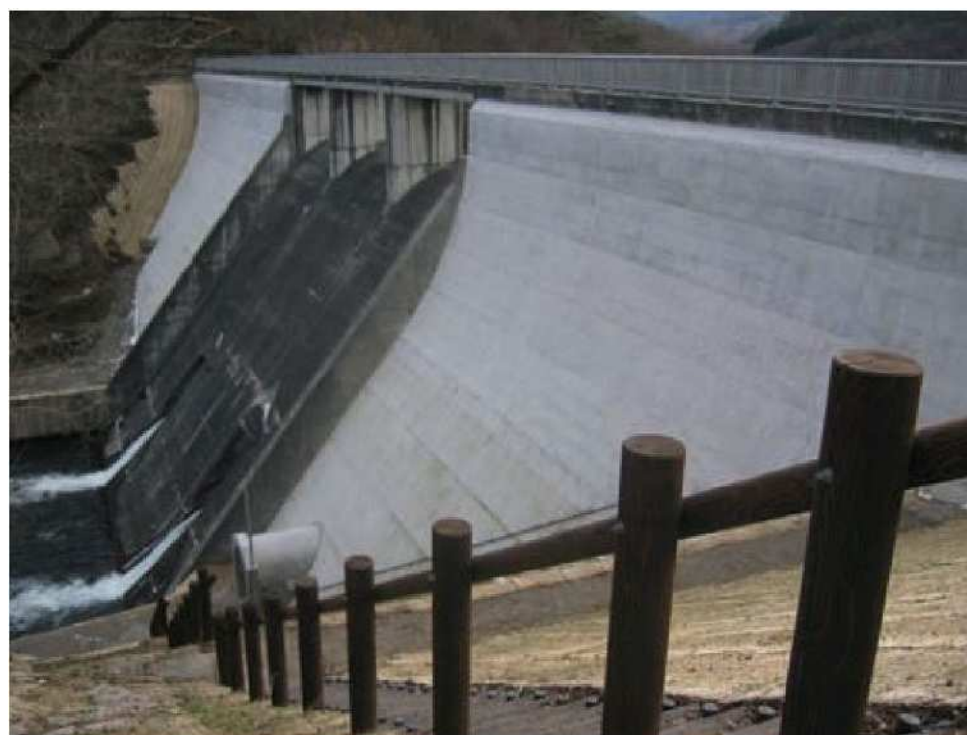
写真-巻-41 堤体下流面補修完了（左岸から）
