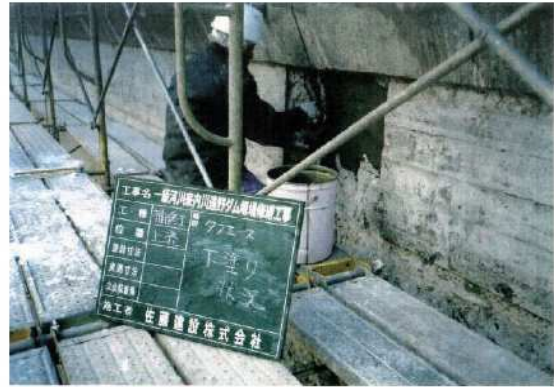
写真-巻-20 補修材下塗り（タフエース）
