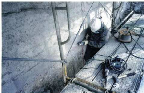
写真-巻-8 補修部カッター処理
