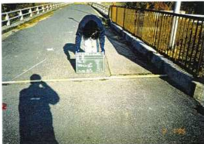
下流側から撮影
