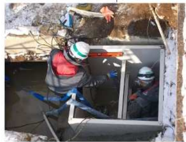
③ 計器保護管設置
