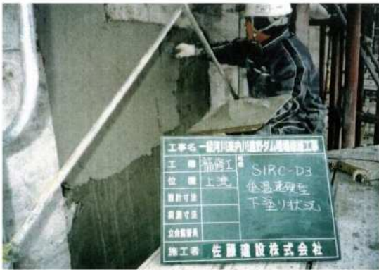
写真-巻-13 補修材下塗り（SIRC-D3）
