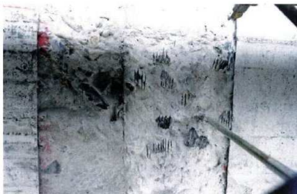
写真-巻-10 補修部骨材カッター処理
