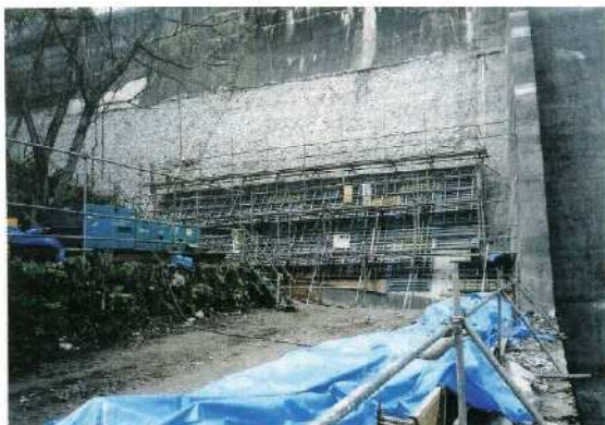
写真-巻-34 型枠設置完了
