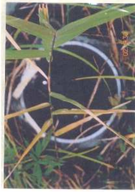
堤体下流側漏水の計測例: 塩ビ管を地中に埋設することにより自由水面を把握することが可能となる。簡易な方法として、内側にφ50mm程度のパイプを立て、竹ひごにピンポン玉を接着したもので計測することも可能。
