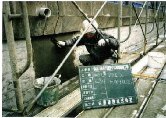
写真-巻-21 補修材上塗り（タフエース）
