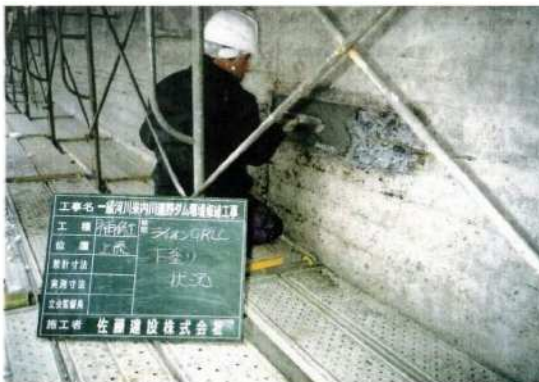
写真-巻-17 補修材下塗り （ライオン GRLC）
