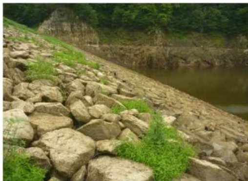
⑦堤体上下流斜面の状況
