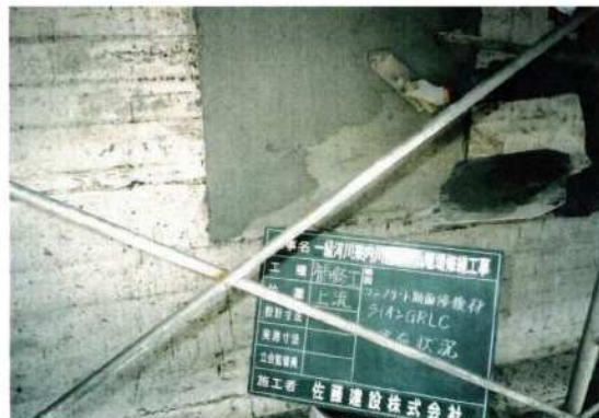
写真-巻-18 補修材上塗り （ライオン GRLC）
