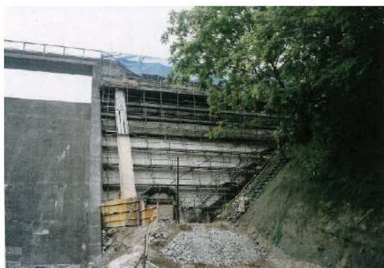
写真-巻-25 足場設置状況（左岸側）
