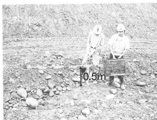
復旧時（平成 17 年）
