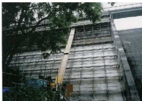
写真-巻-26 足場設置状況（右岸側）
