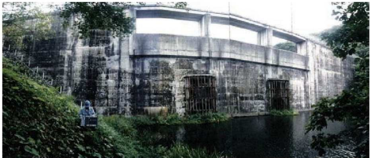
写真-巻-23 堤体上流面着手前状況
