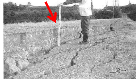
写真-1 浅河原調整池の段差地形
