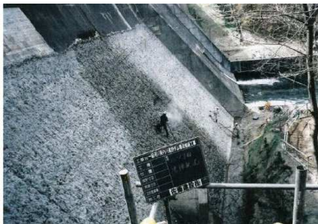
写真-巻-29 ハツリ面洗浄状況
