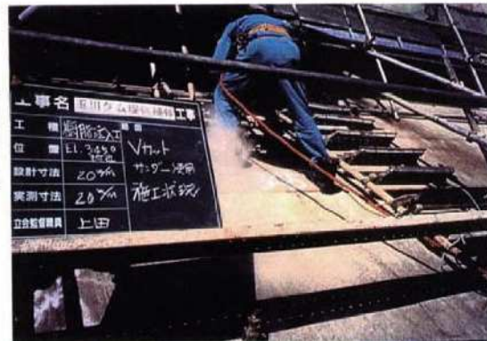
写真-巻-1 越流部中央の縦クラックの工事状況
