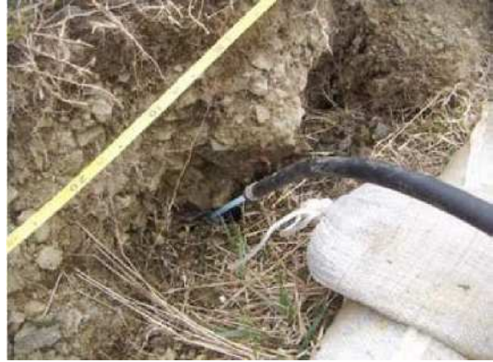
写真-5.2-5 石灰水注入状況（ポンプ注入）
