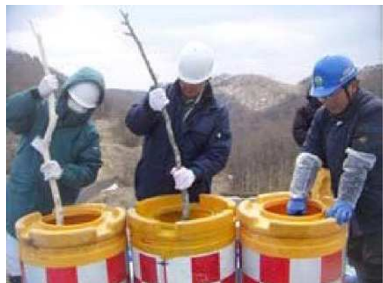
写真-5.2-3 石灰水を攪拌している状況
