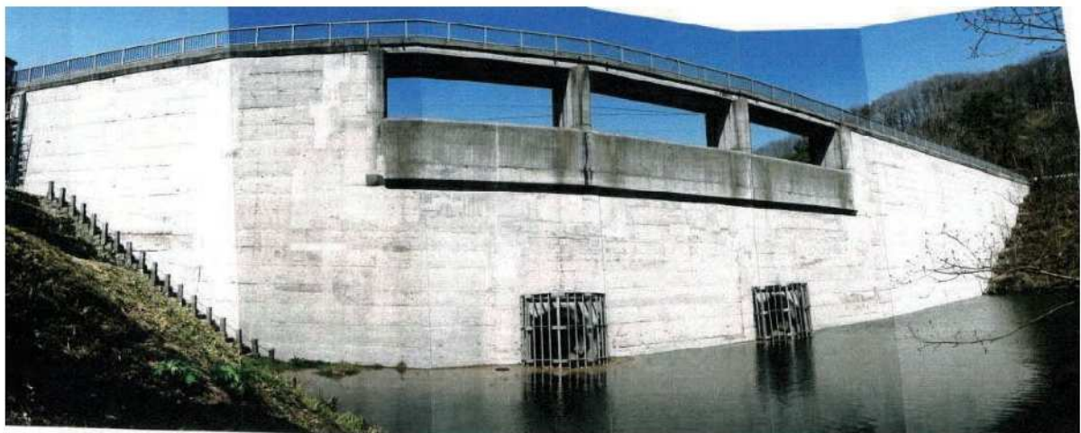
写真-巻-24 堤体上流面補修完了
