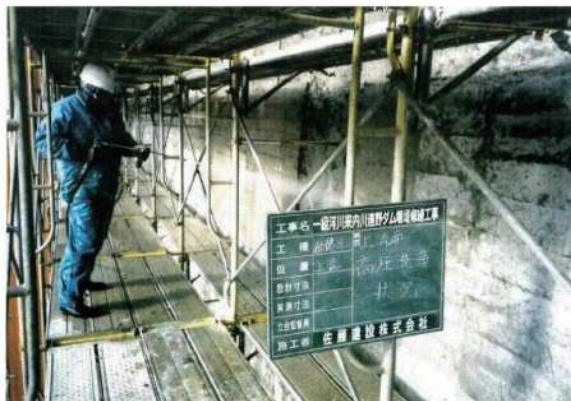
写真-巻-11 補修部洗浄状況
