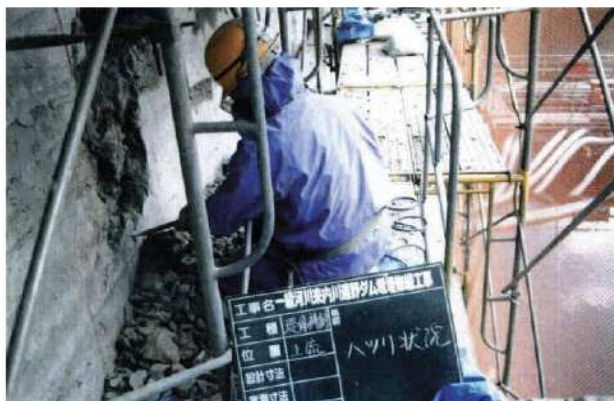
写真-巻-9 補修部ハツリ処理
