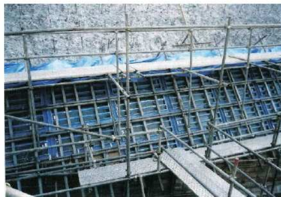
写真-巻-34 型枠設置完了
