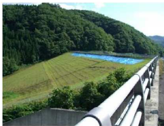
写真-5.3-2 下流法面クラックのブルーシートによる保護（衣川1号ダム）
