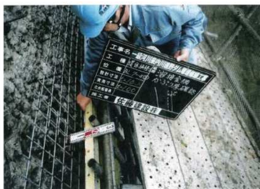
写真-巻-33 溶接金網かぶり確認
