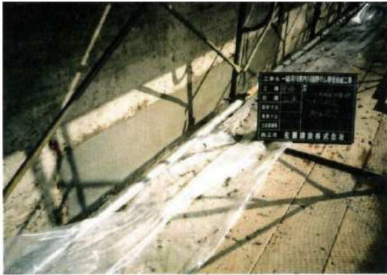
写真-巻-19 補修完了（ライオンGRLC）
