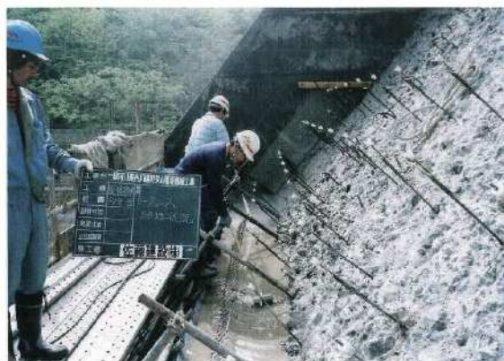
写真-巻-39 レイタンス処理
