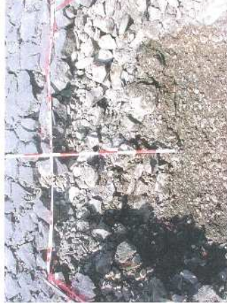
トレンチ掘削箇所
