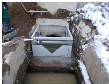
④ 応急施設設置完了
