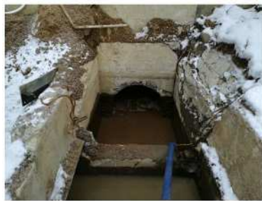
① 施工前 (既設観測施設水標)
