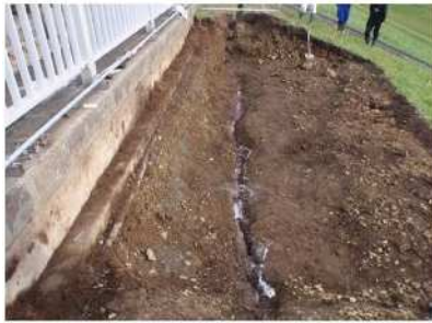
⑦100cm掘削面の観察 (写真撮影、スケッチ、クラック幅などの観察) 石灰水の注入80L
