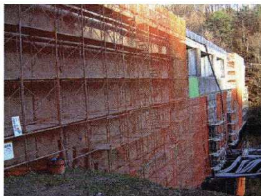
写真-巻-4 上流面足場
