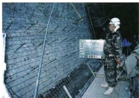
写真-巻-32 溶接金網設置完了
