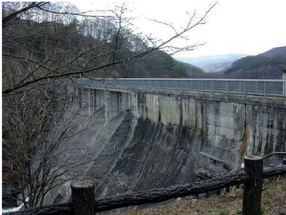
写真-巻-40 堤体下流面着手前状況（左岸から）
