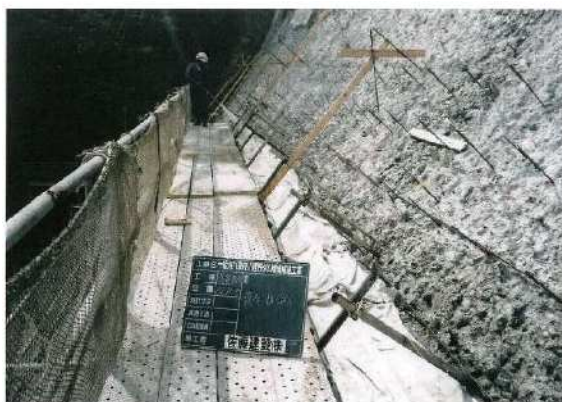
写真-巻-38 養生状況
