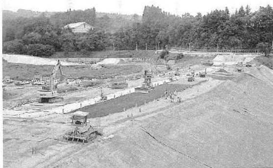
写真-3 盛立全景 (浅河原調整池)
