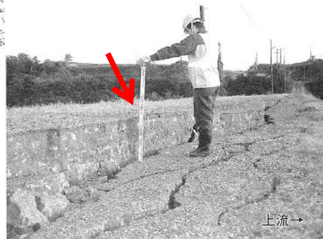
写真-1 浅河原調整池の段差地形
