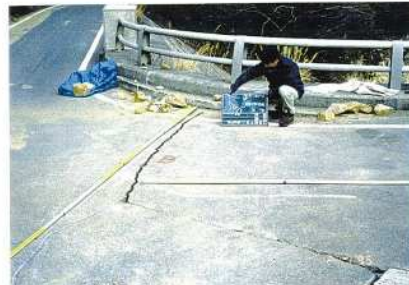
下流側から撮影
